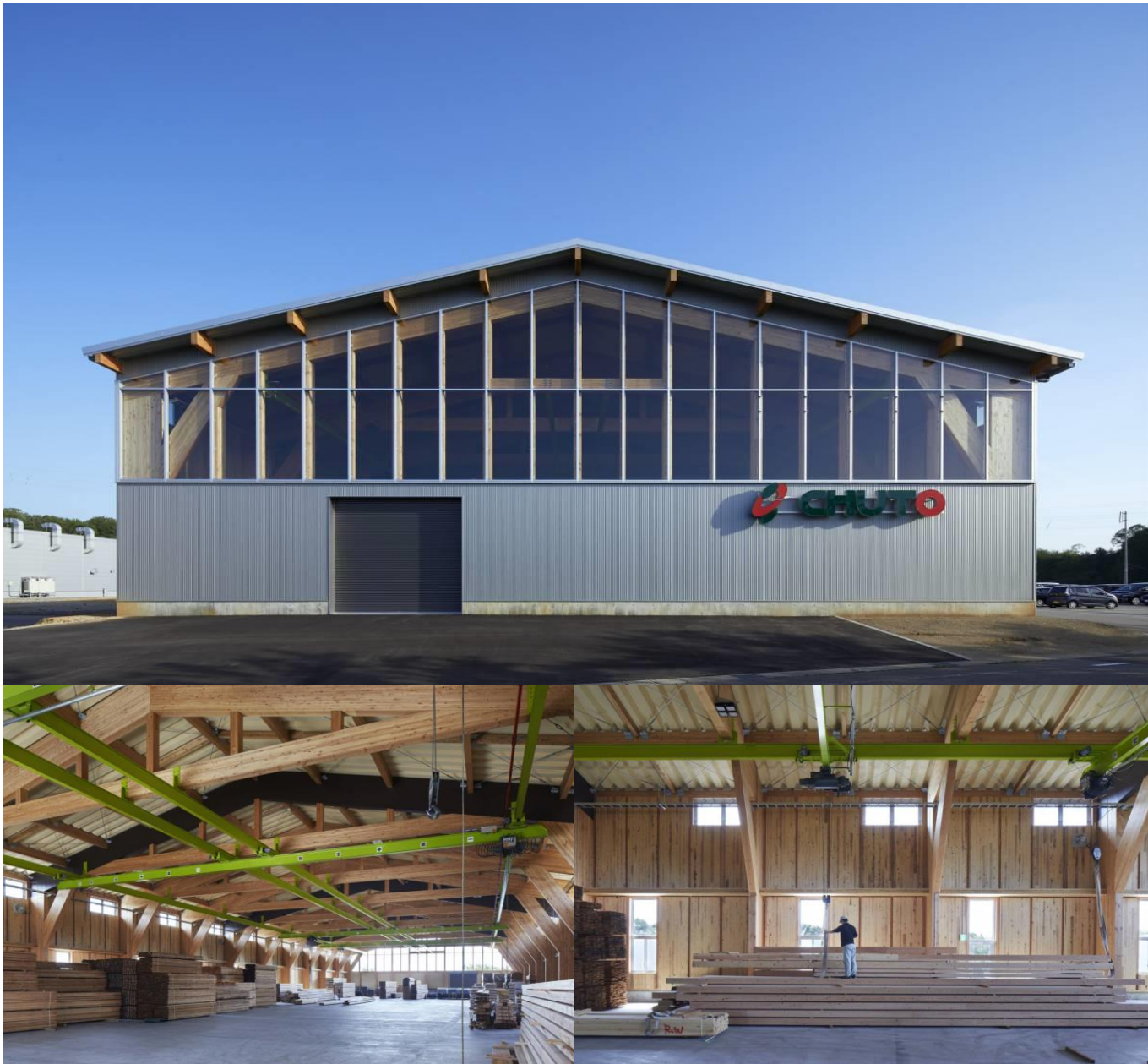
写真提供：(株)梶谷建設
