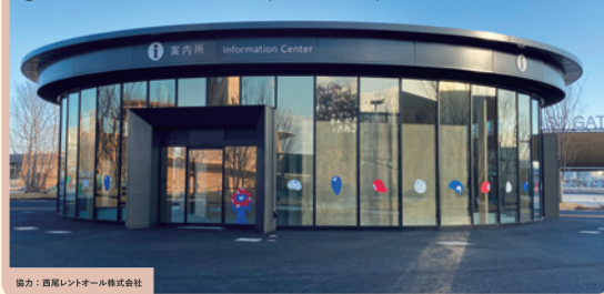
④東ゲート広場案内所(内部の壁)
