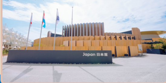
①日本館(壁)
