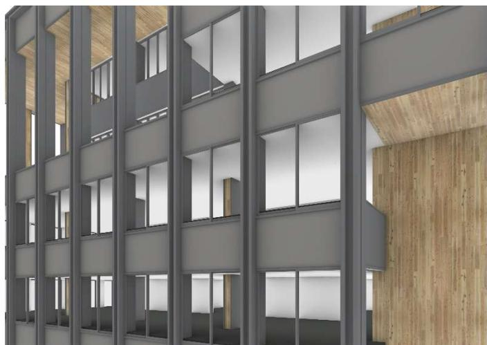
図 2.2-4 住宅用サッシを用いて構成された開放的なファサード
