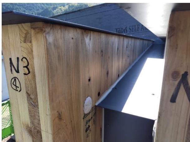
[図. 調査箇所④上部-鋼製笠木周辺部・CLT3 側面 (例：北面)]
