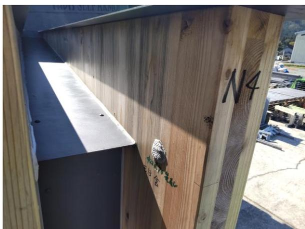
[図. 調査箇所④上部-鋼製笠木周辺部・CLT4 側面 (例：北面)]
