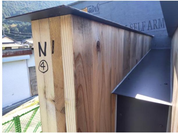
[図. 調査箇所④上部-鋼製笠木周辺部・CLT1側面（例：北面）]
