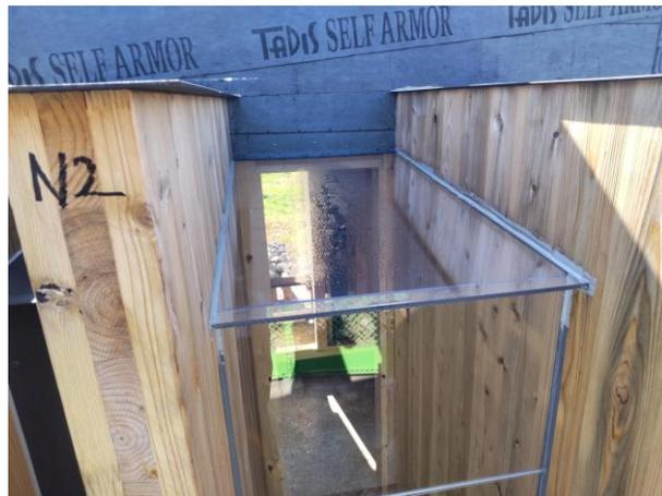
[図. 調査箇所⑥CLTパネル間採光スペース（例：北面）]
