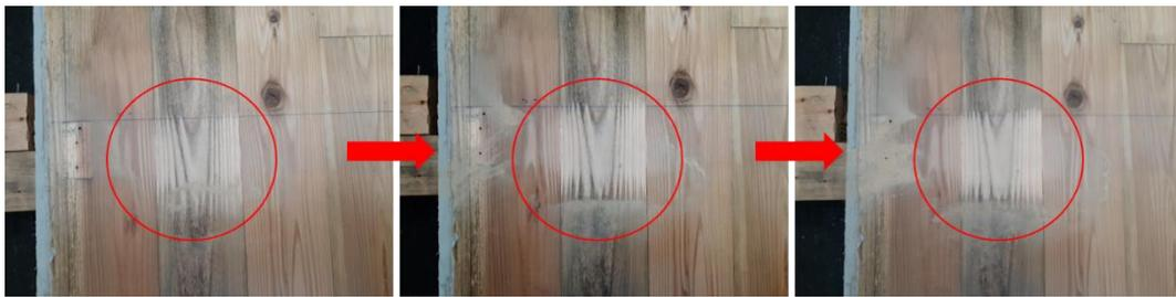
[図.サンダーによる研磨 約 10 秒後 (左)、約 20 秒後 (中央)、約 30 秒後 (右)]
