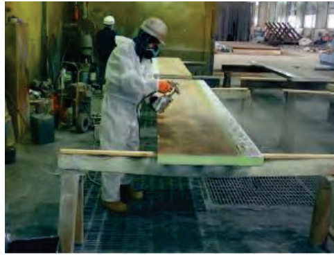
写真 1.3-5 CLT 材への忌避塗料の塗布
