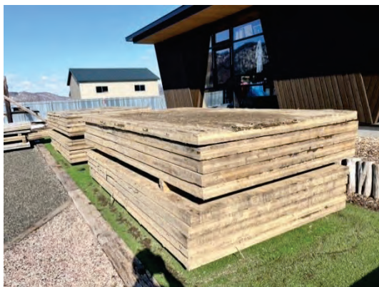
写真 5.1-4 CLT 敷板の保管状況
