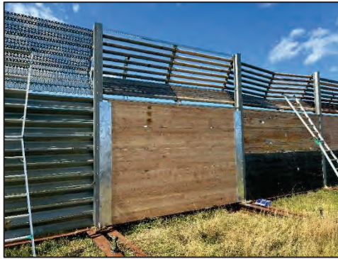
写真 5.3-2 CLT 防雪柵 設置状況
