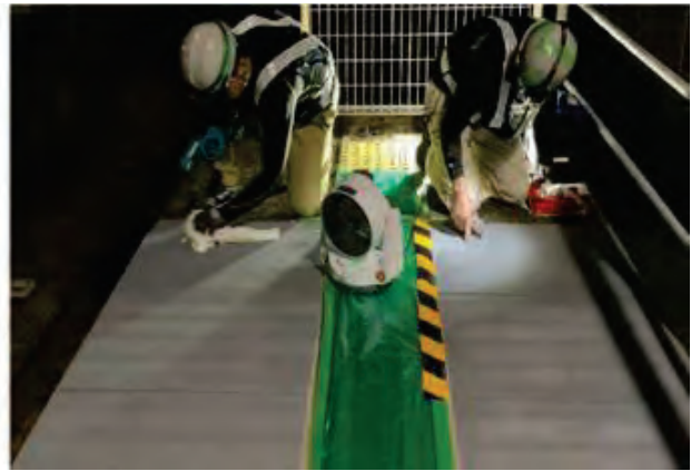
写真 5.2-8 養生・結露乾燥
