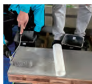
IS シート貼付
