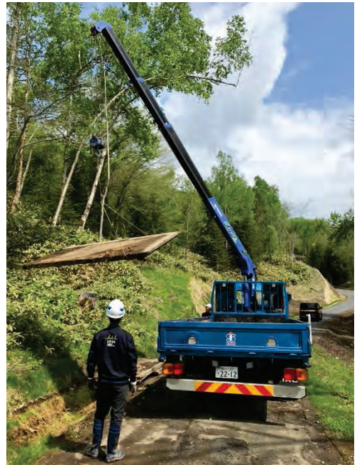
写真 5.1-7 小型クレーン車による積み下ろし
