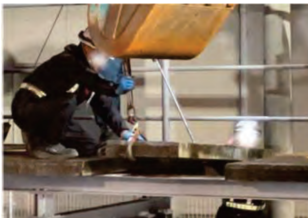
写真 5.2-4 既設床板の撤去
