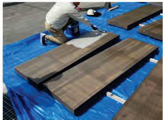
写真 5.2-2 塗装作業(左:防水工1層目、右:防水工2層目)
