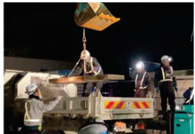
写真 5.2-4 既設床板の撤去
