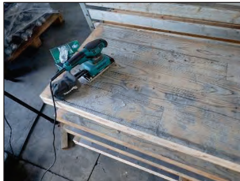
写真 5.3-6 表面の塗料をサンドペーパーで除去
