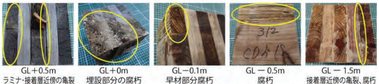
写真 1.1-3 地盤環境・温帯(三次) キュービック供試体の劣化状況
