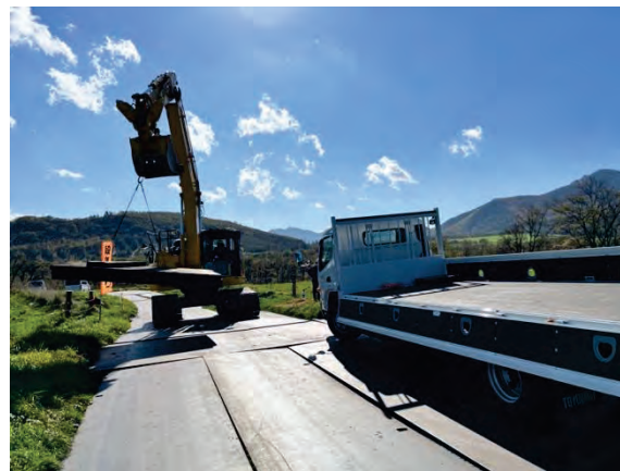
写真 5.1-8 油圧ショベルによる積込の様子
