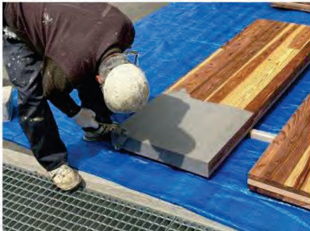
写真 5.2-2 塗装作業(左:防水工1層目、右:防水工2層目)
