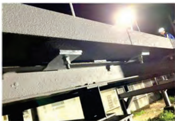
写真 5.2-6 CLT 床板の設置（左:ボルト固定状況、右:設置完了）
