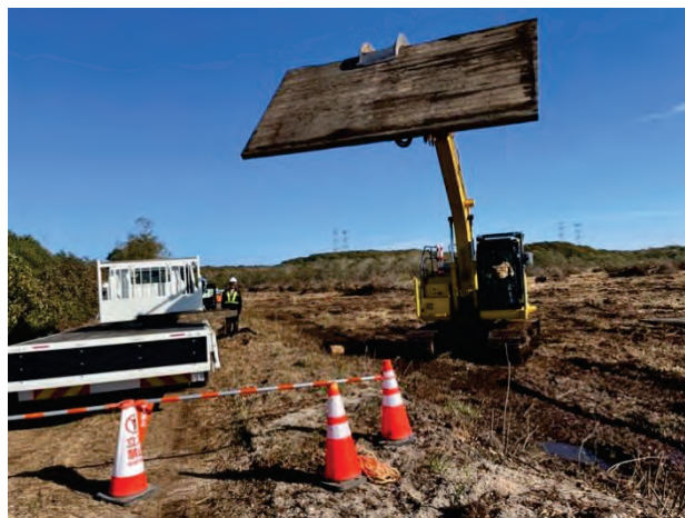
写真 5.1-9 グラップルによる積み下ろしの様子
