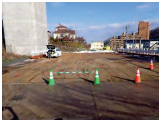
写真 5.1-1 測定対象 1：天神トンネル（小樽市）に 敷設した CLT 敷板
