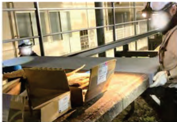
写真 5.2-5 CLT 床板の設置
