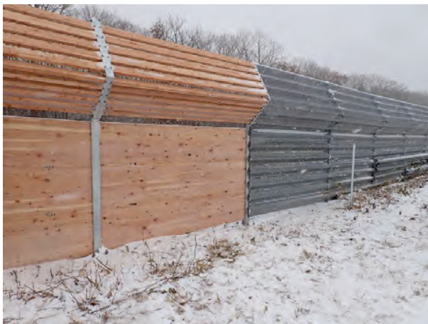
図 6.1-1 左:CLT 防雪柵、右:鋼製防雪柵
