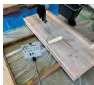
プライマー工
