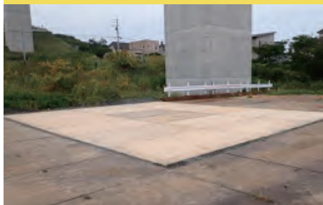
土木工事現場 車両待機場
