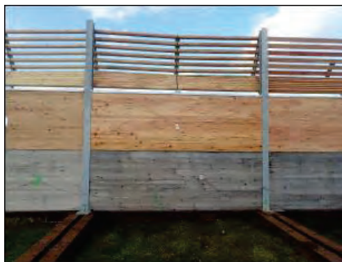
写真 1.3-4 表面が無処理の CLT を用いた防雪柵 (上半分が表面処理あり、下半分が無処理)
