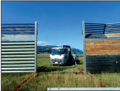
写真 5.3-4 1 スパン CLT 防雪板を撤去
