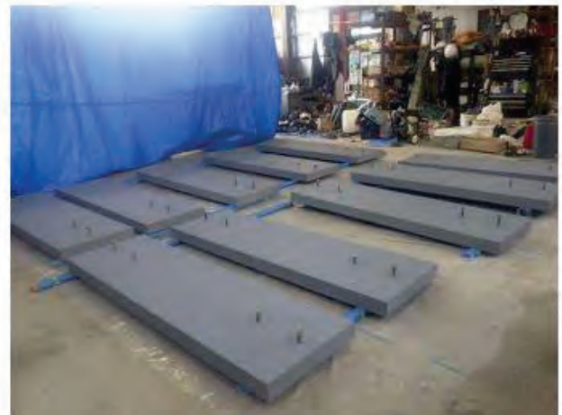
写真 5.2-3 塗装作業(左:保護工1層目、右:保護工2層目完了)
