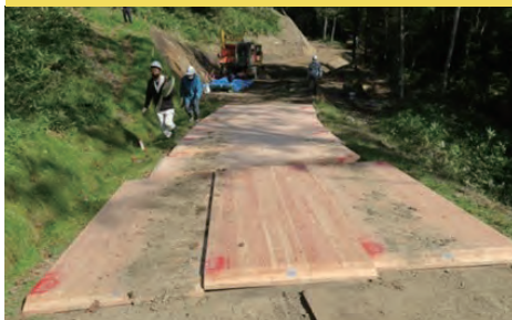
林道工事現場
