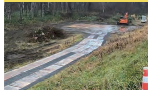
河川敷工事現場
