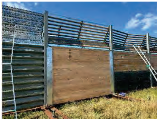
写真 1.3-3 北海道内で加工した CLT を用いた防雪柵
