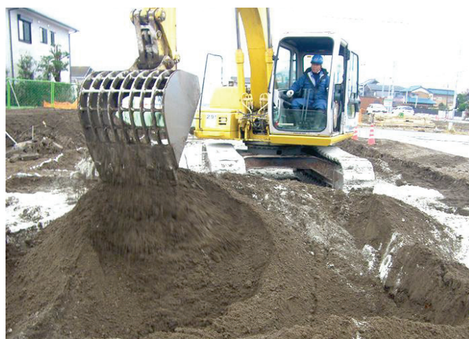
写真-6 表層混合処理工法の施工状況
