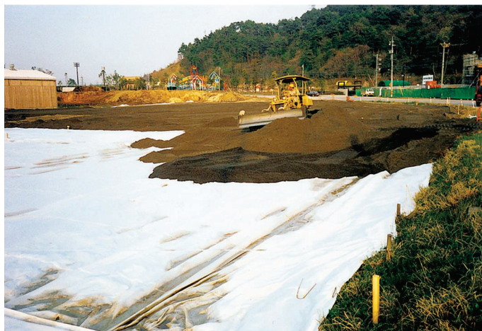
写真-1 安定シートによる軟弱地盤表層安定処理工
