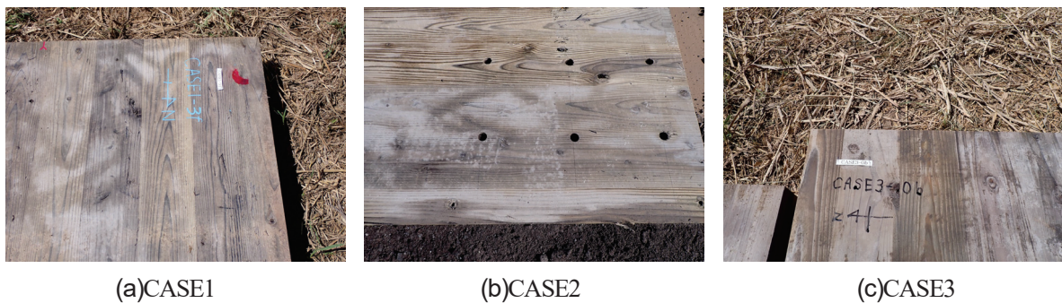
写真-10 1.8 年経過後掘出した CLT 表面の状況
