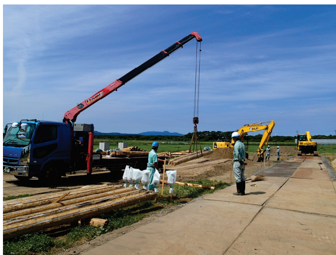
写真-2 敷設された敷き鉄板の状況
