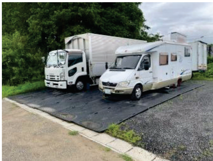
写真-3 敷設されたプラスチック敷板 ※4
