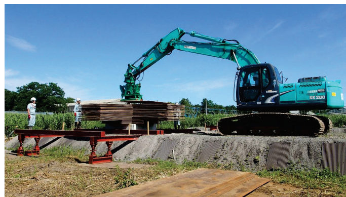
写真-8 大型載荷試験の様子
