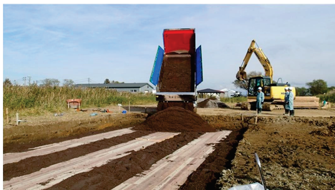
(d)盛土材の投入状況
