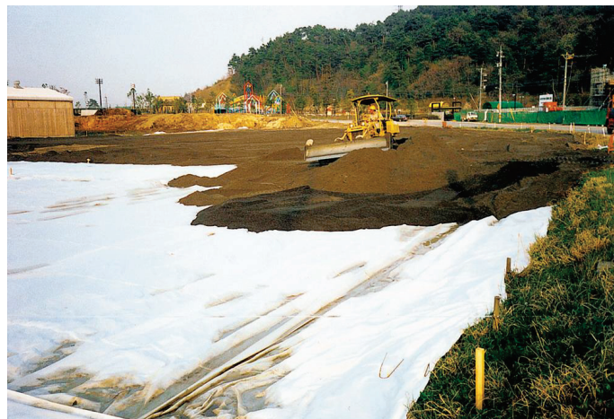
写真-5 安定シートによる軟弱地盤表層安定処理工
