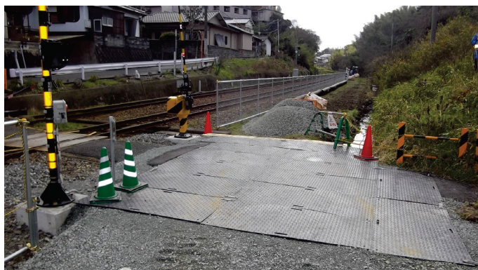
写真-4 敷設されたウッドプラスチック敷板 ※5
