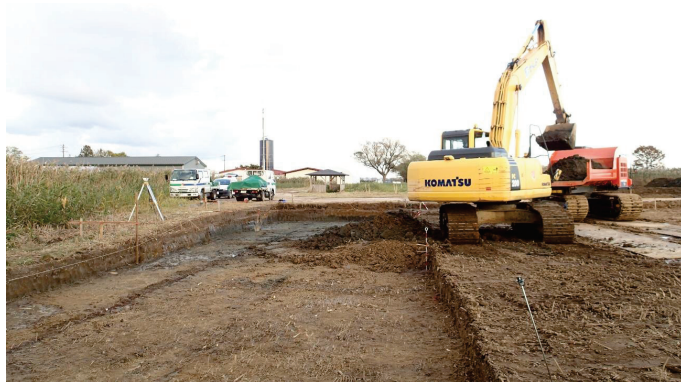
(a)地盤の掘削状況
