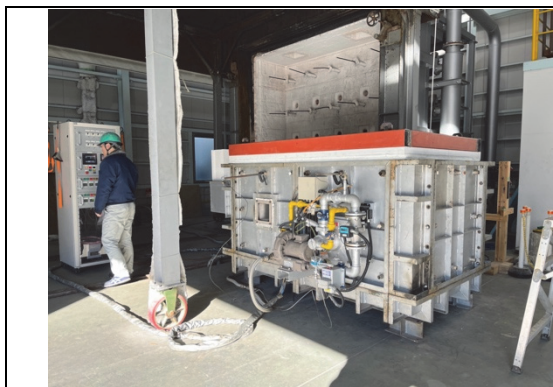
写真 4.2-9 小型耐火炉の全景
