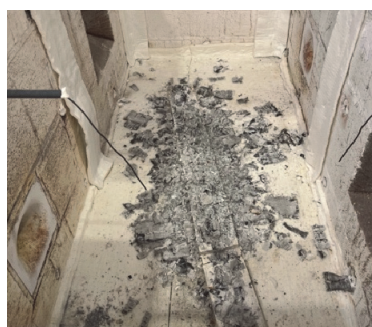
写真 4. 3-10 CLT の焼失状況 (実験後の炉内) (No. 1)
