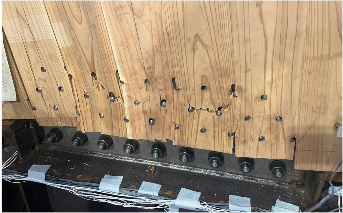
写真 3. 3-6 セン断破壊のラミナのずれ (No. 2b)
