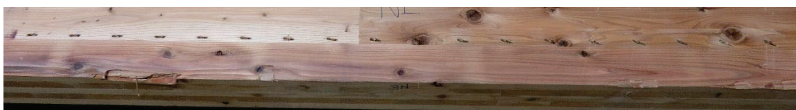
(h)ビス孔の状況 [固定側大梁－北側CLTパネル(東側)]
