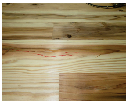
(b) CLTパネルの割り裂き
