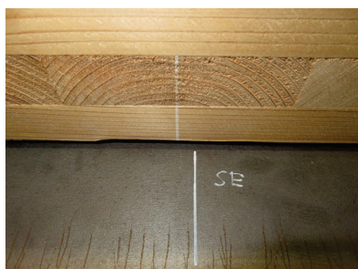
(g) 加力側大梁-南側CLTパネルのずれ [東側]
