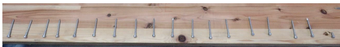
(c)ビスの状況 [加力側大梁－南側CLTパネル(東側)]
