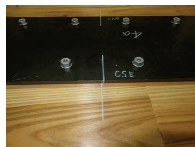
(l) スプライン接合部のずれ [北東側]
