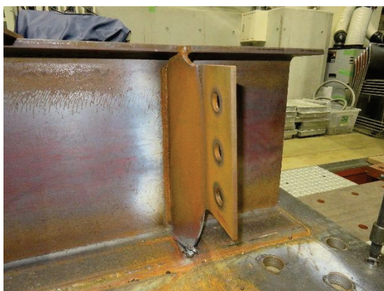
(c) 固定側大梁ガセットプレートの状況〔東側〕
