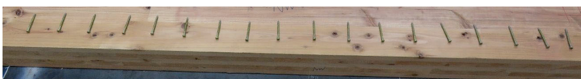
(c)ビスの状況 [加力側大梁－南側CLTパネル(東側)]
