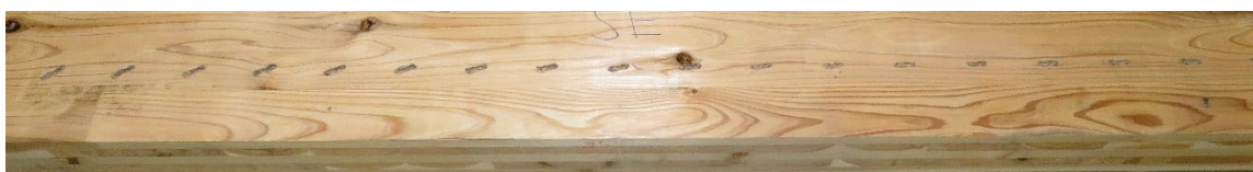
(g)ビス孔の状況 [加力側大梁－南側CLTパネル(西側)]
