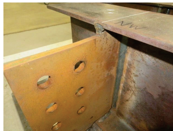
(h) 固定側大梁ガセットプレートの状況 [西側]
