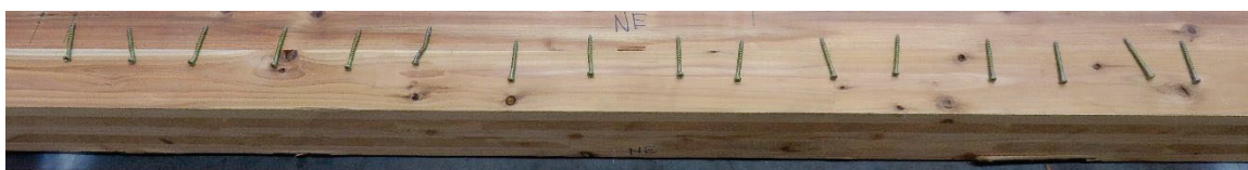
(d)ビスの状況 [加力側大梁－南側CLTパネル(西側)]
