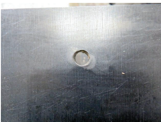
(e) 鉄骨梁上側接合の状況 [鋼板側]
