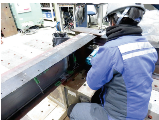
(a) 鉄骨フレームの施工状況
