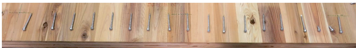
(a)ビスの状況 [非加力側小梁－北側CLTパネル]
