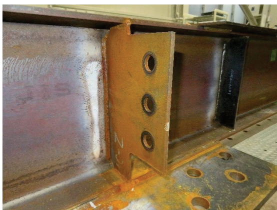
(f)固定側大梁ガセットプレートの状況〔西側〕
