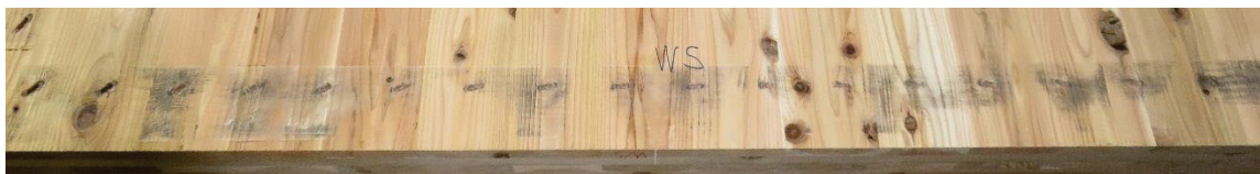
(a)ビス孔の状況 [加力側小梁－南側CLTパネル]
