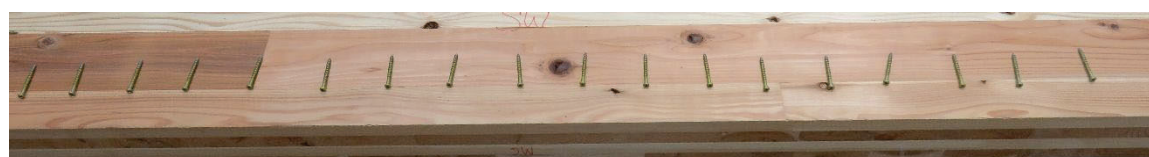
(h) ビスの状況 [固定側大梁－北側CLTパネル(東側)]
