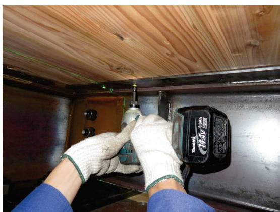
(b) ビスの打ち込み状況
