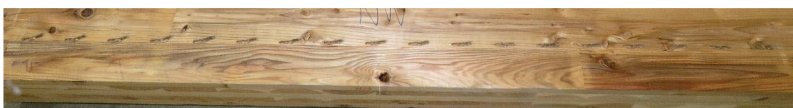
(c)ビス孔の状況 [固定側大梁－北側CLTパネル(西側)]
