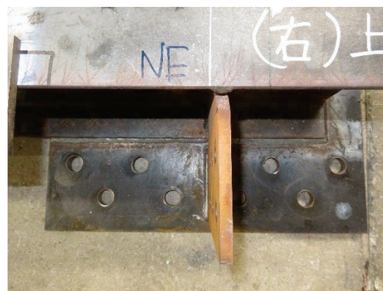
(f) 固定側大梁ガセットプレートの状況 [東側]
