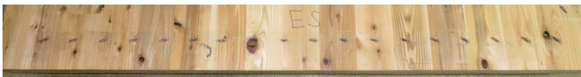
(f)ビス孔の状況 [非加力側小梁－南側CLTパネル]
