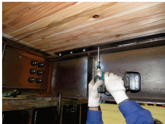
(b) ビスの打ち込み状況
