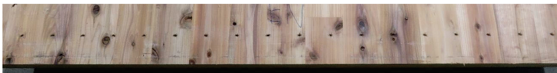
(a)ビス孔の状況〔非加力側小梁－北側CLTパネル〕
