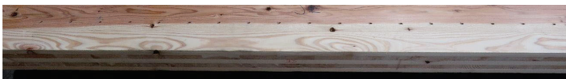
(c)ビス孔の状況〔加力側大梁－南側CLTパネル(西側)〕
