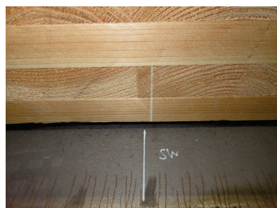
(h) 加力側大梁-南側CLTパネルのずれ [西側]
