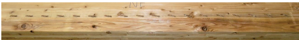
(d)ビス孔の状況 [固定側大梁－北側CLTパネル(東側)]
