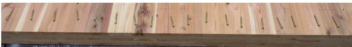
(b)ビスの状況 [非加力側小梁－南側CLTパネル]
