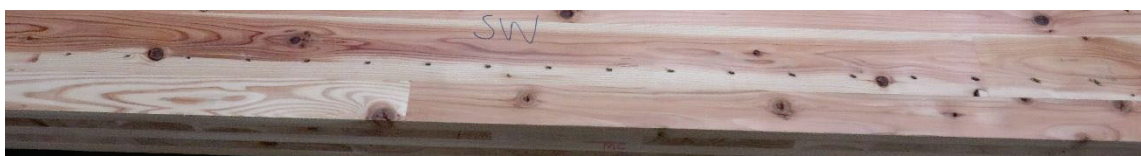
(d)ビス孔の状況〔加力側大梁－南側CLTパネル(東側)〕
