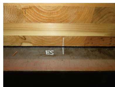
(f) 非加力側小梁-南側CLTパネルのずれ
