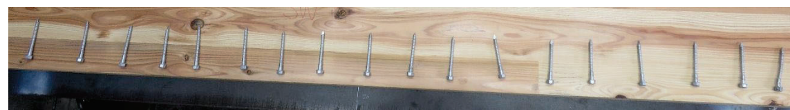
(d) ビスの状況 [加力側大梁－南側CLTパネル(西側)]
