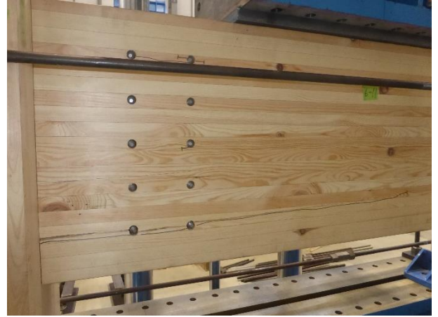
写真 3 試験終了後の状況 番号:0 ・梁の割れ
