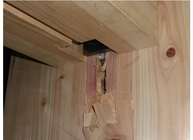
写真 5 試験終了後の状況 番号:1 ・六角ボルトの破断
