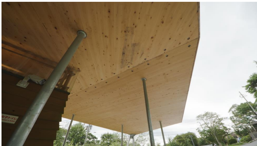
建物外観（天井部分）
