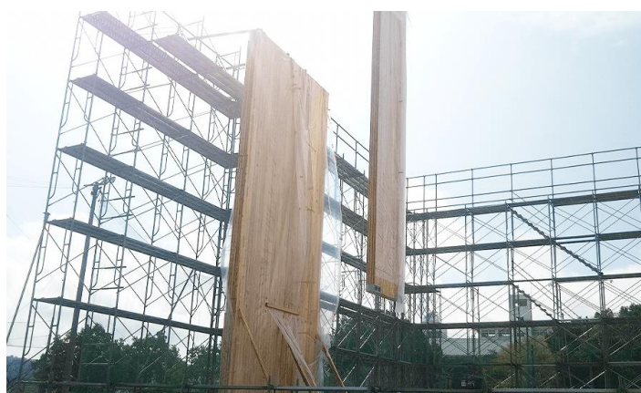
図 1.2 CLT パネルの建方
