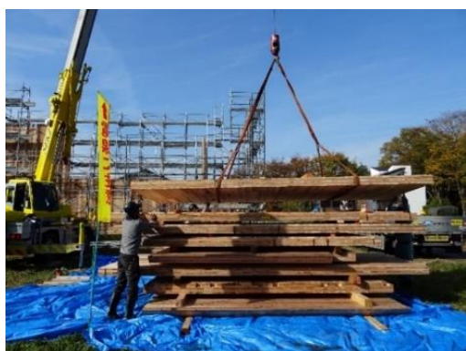
図 4.2 ベルトスリングでの荷下ろし
