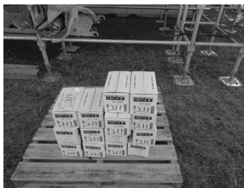
図 4.3 金物・ボルト類の保管
