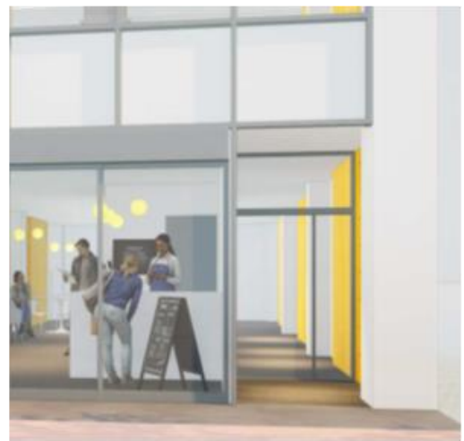
図 4.5-2 エントランスの現しCLTパネル
