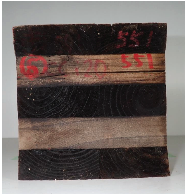
写真 5.1.3-4 ラミナの亀裂
