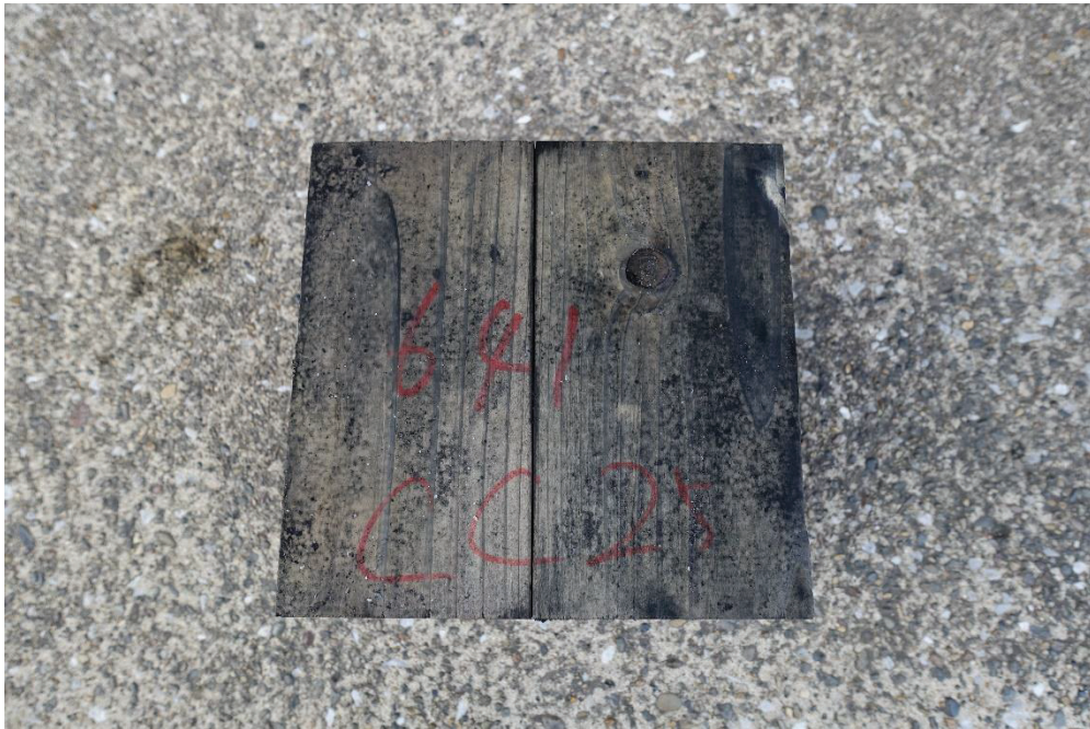
写真 4.1.7-3 幅はぎ部分に隙間
