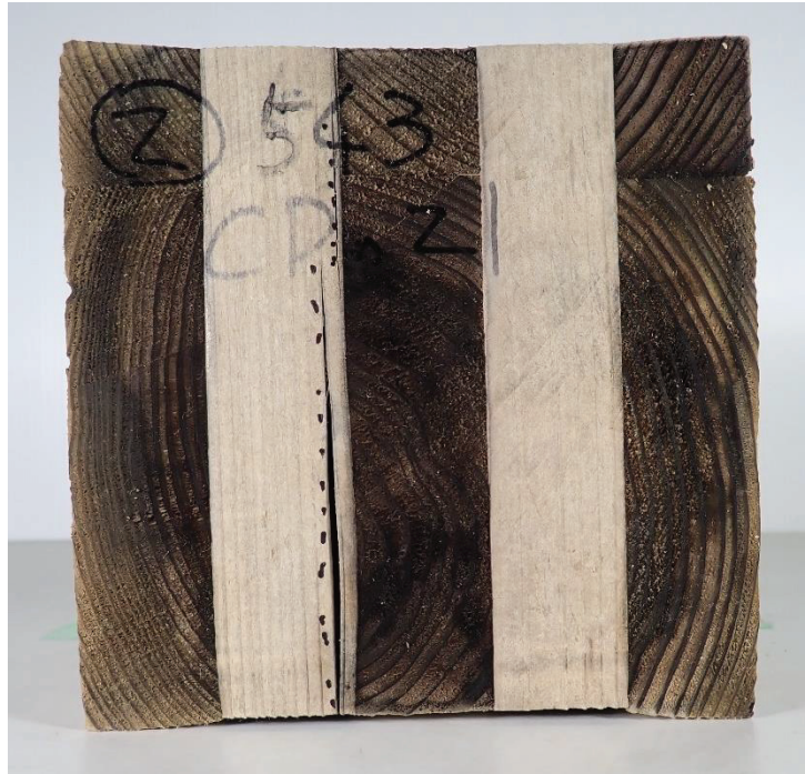
写真 5.1.5-1 ラミナの亀裂
