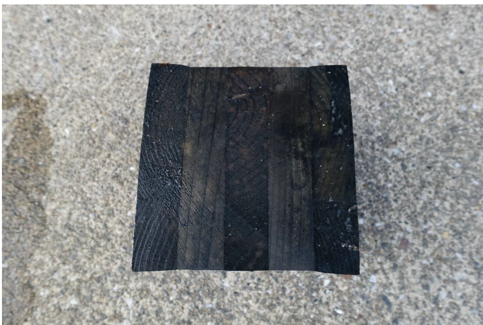
写真 4.1.5-2 土中部分黒色に変色
