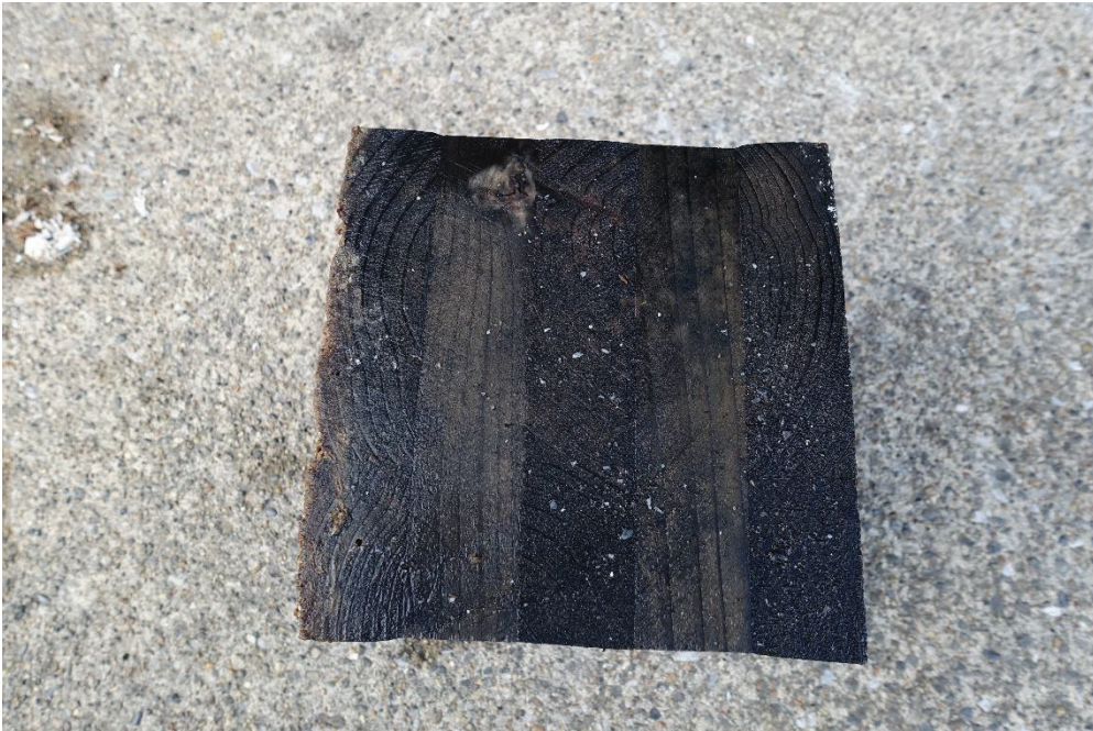
写真 4.1.4-2 土中部分は黒色に変色
