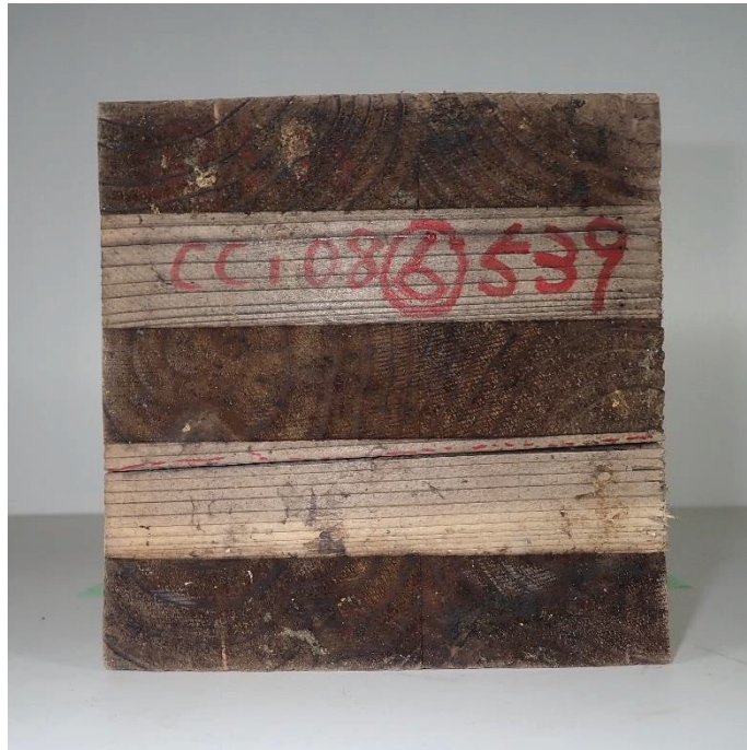
写真 5.1.1-3 ラミナの亀裂
