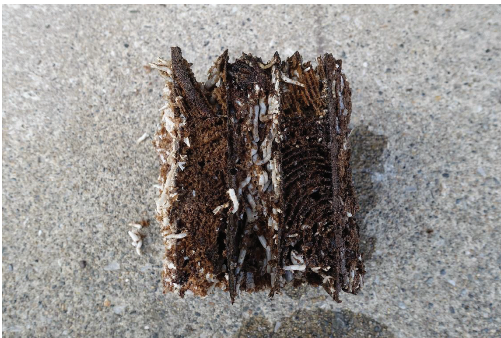
写真 4.1.1-2 接着層を残して原形を留めていない
