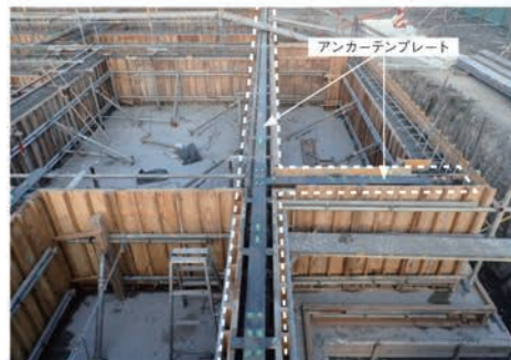
鋼材のフラットバー FB-6×125にアンカーボルトの孔を開けたアンカーテンプレートをCLT壁パネルごとに設置し、アンカーボルトの相対位置の精度を高めた
