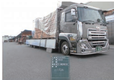
CLTパネル運搬
