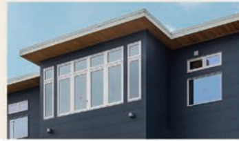
CLTパネルを現した軒天
