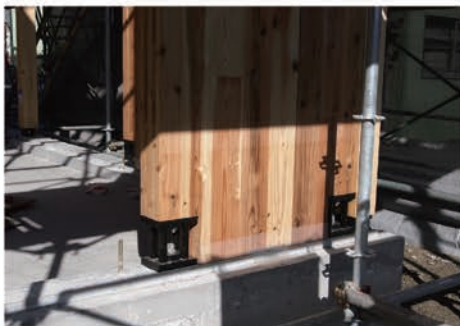
CLTパネル躯体工事 CLT壁パネル脚部
