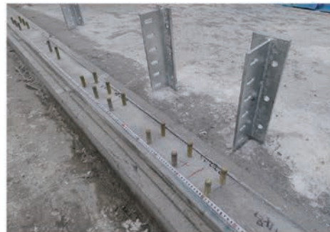
アンカーボルト位置の測定
