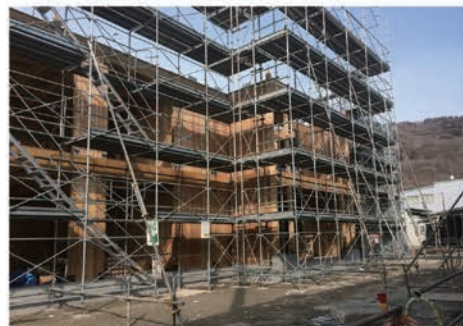
CLTパネル躯体工事 躯体外観
