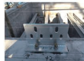
CLT柱脚せん断金物
