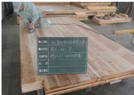
CLTパネル加工仕上げ作業
