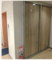
CLT壁をガラスパネルで覆った2階昇降路
