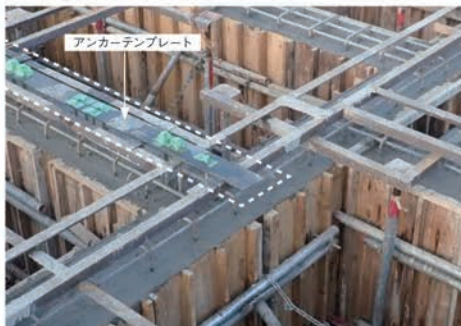
鋼材のフラットバー FB-6×125にアンカーボルトの孔を開けたアンカーテンプレートをCLT壁パネルごとに設置し、アンカーボルトの相対位置の精度を高めた
