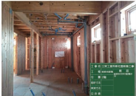
③ 2階女子トイレ・給湯室・多目的トイレ
