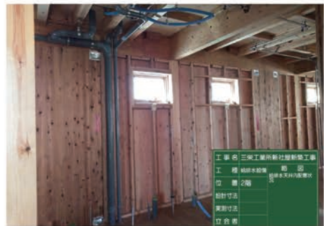
② 2階多目的トイレ・男子トイレ
