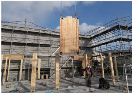
CLTパネル揚重
