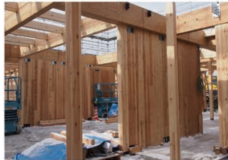
CLTパネル躯体工事 躯体内部
