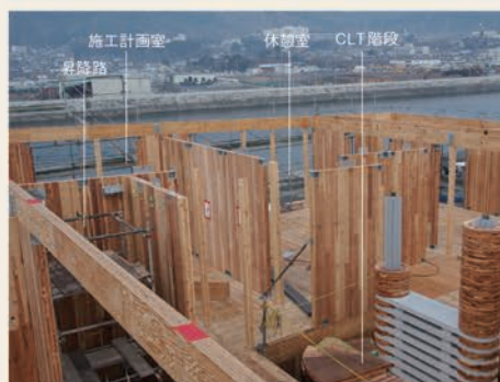
3階 CLTパネル施工状況
