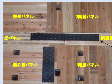
写真2.2.4-2 耐風梁-床パネル間引張接合部の例
