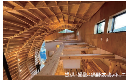
パネル (36mm厚CLT) で構成された ヴォールト屋根の家 山形県東根市 (屋根、棚)
