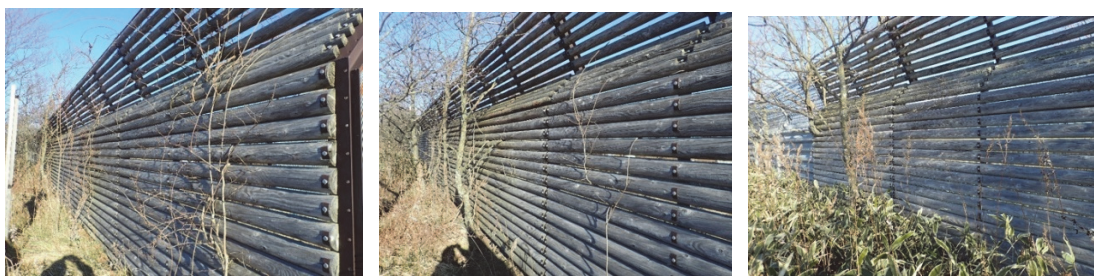
写真 2.1-3 現在の木製防雪柵の状況(左:無処理、中央:防腐剤加圧注入処理、右:封孔材塗布処理)
