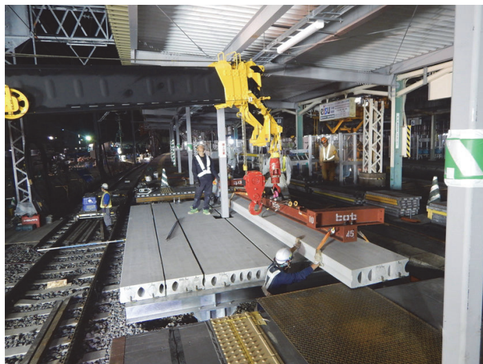
写真 2.2-8 穴あきPC板の施工事例(坂口建設ウェブサイトより抜粋)
