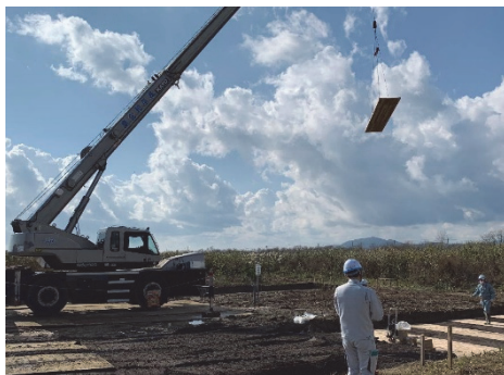
写真 3.1-3 CLT の吊り上げ、敷設
