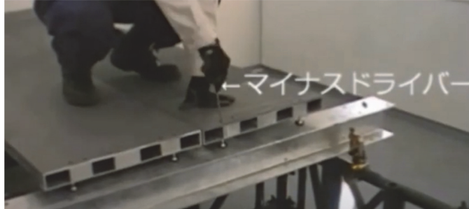
写真 2.2-4 マイナスイドライバーによる上部からの高さ調整
