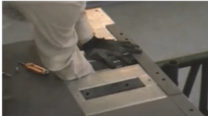
写真 2.2-5 デッキ上からの固定金具による固定
