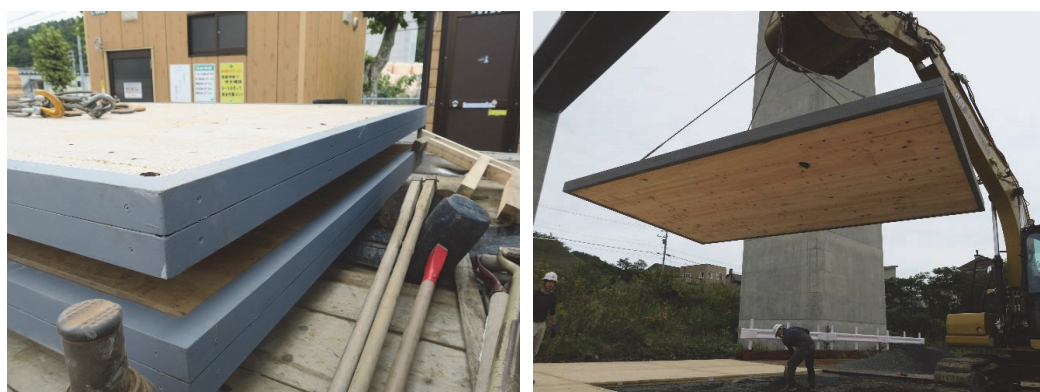
写真 3.2-1 端部補強した CLT 敷板
