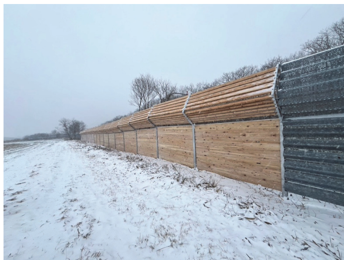
写真 2.1-2 実証実験で設置された CLT 防雪柵と既存の高性能防雪柵(手前)
