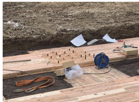
写真 3.1-4 丸鋼での固定(CASE2)
