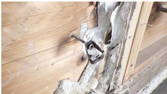
写真 3-29 仕様 12 の解体時 (CLT 表面)
