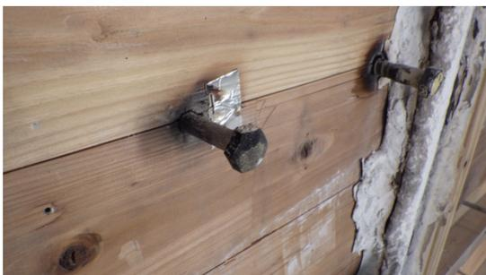
写真 3-11 仕様 3 の解体時 (CLT 表面)
