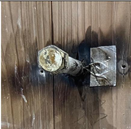
写真 2-45 仕様 21 の解体時 (CLT 表面)
