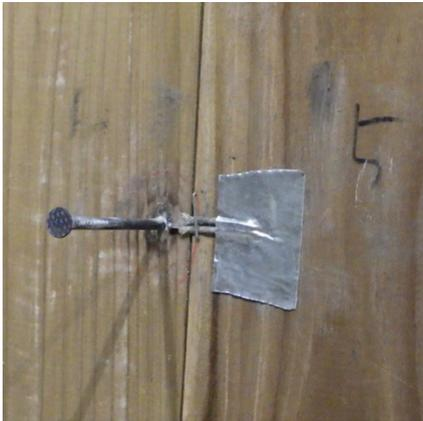
写真 1-21 仕様 1 の解体時（CLT 表面）
