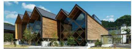
銘建工業本社事務所
