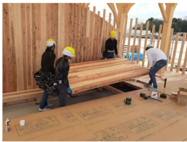
作業員によって人力で運搬された床のCLT
