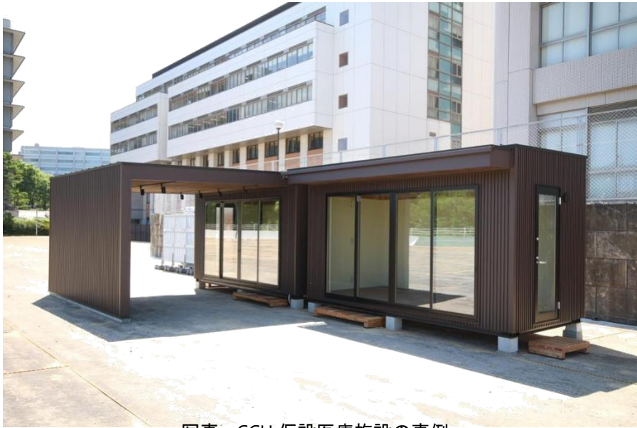
写真 CCU 仮設医療施設の事例 (仮設 PCR 検査場 ユニット2体使用 近接配置 設置1日)
