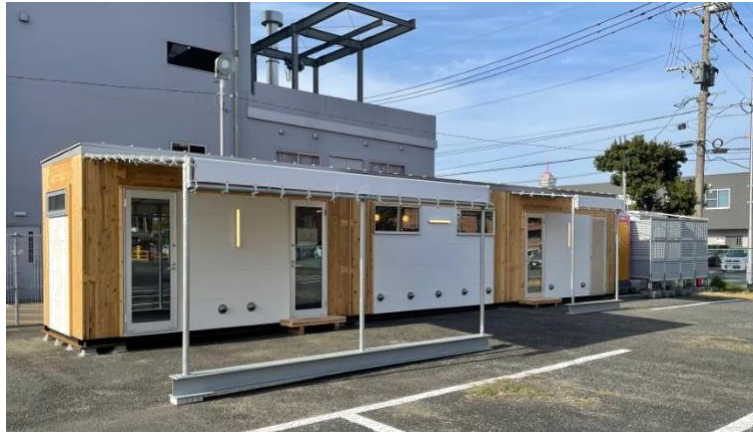
写真 CCU 仮設医療施設の事例 (仮設 PCR 検査場 ユニット 3 体使用 隣接配置 設置1日)
