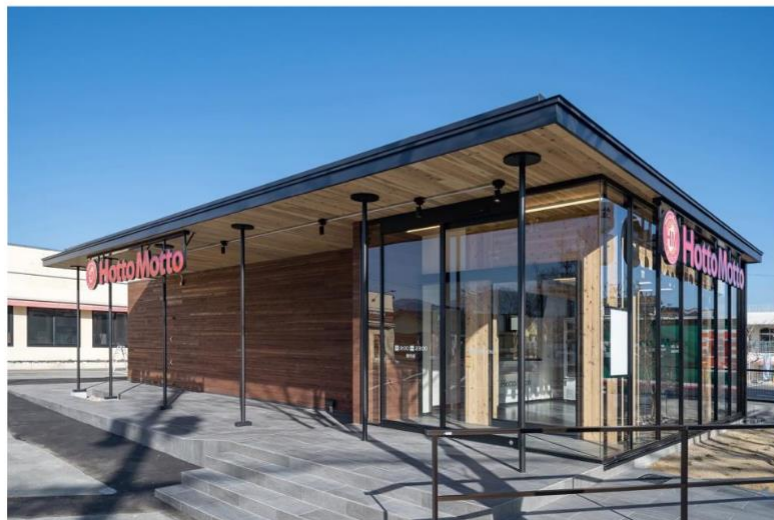
写真 CCU を構造体として建築された店舗の事例。 (HottoMotto 野芥店 平屋 2UNIT 使用 離隔配置 工期 約 1.5 ヶ月)
