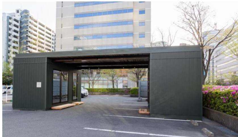
写真 CCU 仮設医療施設の事例 (仮設 PCR 検査場 ユニット2体使用 離隔配置 設置1日)
