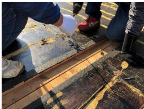
写真 屋根防水部分の解体時
