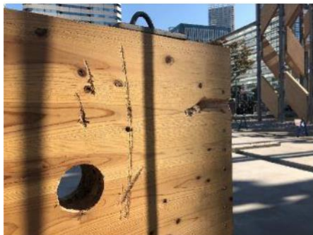
写真 CLT の損傷
