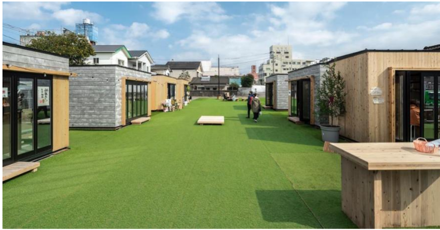
写真 CCU 仮設店舗の事例 (人吉復興コンテナマルシェ 単体ユニット7体使用 設置1日)
