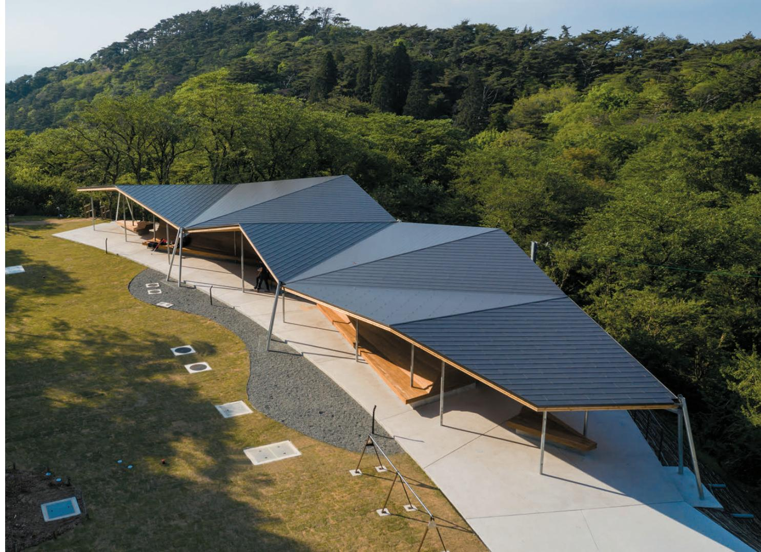
浅く折れつながるCLTで構成した屋根を自然の中に伏せるように配置 撮影：小川重雄(12-15頁)
