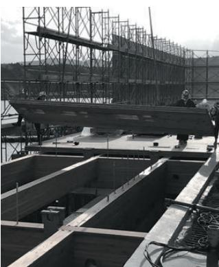
建て方は、6~7人のチーム編成で、クレーンで吊り上げて建て込む。左:床版、右:壁版。
