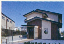
社会福祉法人向陵会 障害者グループホーム ジョイフル上鳥羽新築工事
