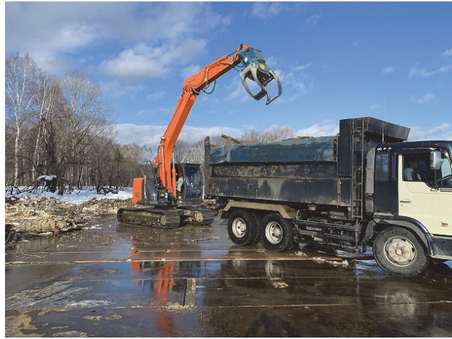
写真 2.2-2 CLT 敷板利用状況 (ヤードでの使用)
