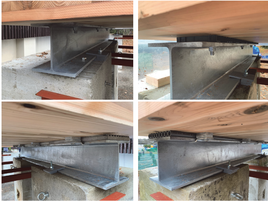
写真 2.1-2 結露対策 4パターン (左上:既存タイプ、右上:基礎パッキン、左下:セメント凸凹プレート、右下:ジグザグプレート)
