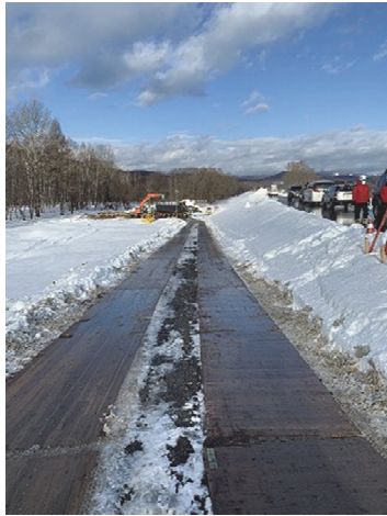
写真 2.2-1 CLT 敷板利用状況 (運搬路での使用)
