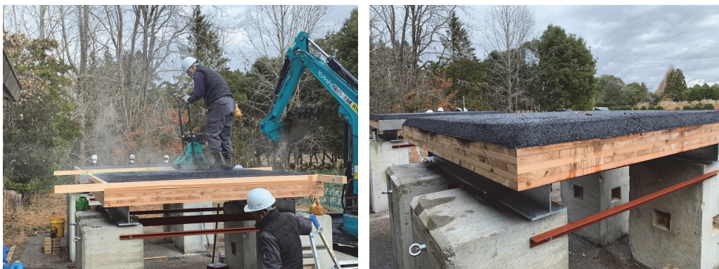
写真 2.1-4 アスファルト舗装の様子
