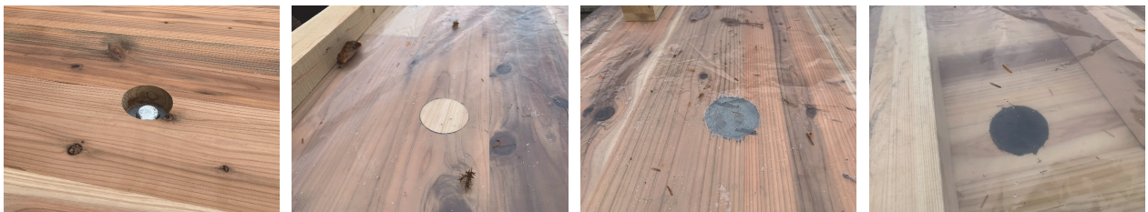
写真 2.1-3 座ぐり部処理方法 4パターン (左から無処理、木栓、モルタル、変性シリコンコーキング)
