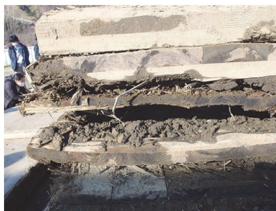
写真 2.2-4 CLT 敷板の損傷 (3 現場利用)
