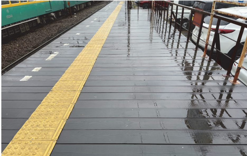
写真 3.2-1 稲荷町駅の 3 番線プラットフォーム
