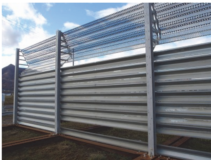
写真 2.3-3 鋼製防雪柵の設置状況 (風下側)
