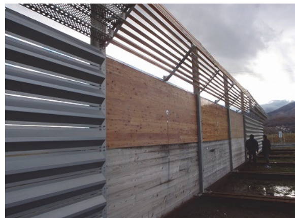
写真 2.3-2 防雪柵の設置状況(風上側)
