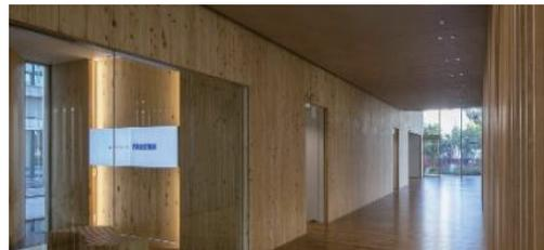
CLT耐震壁+鉄骨ハイブリッド構造
