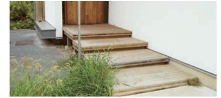
実験棟玄関ステップの腐朽測定では、約7年間雨ざらしの状態ではほとんど腐朽は見られませんでした。
