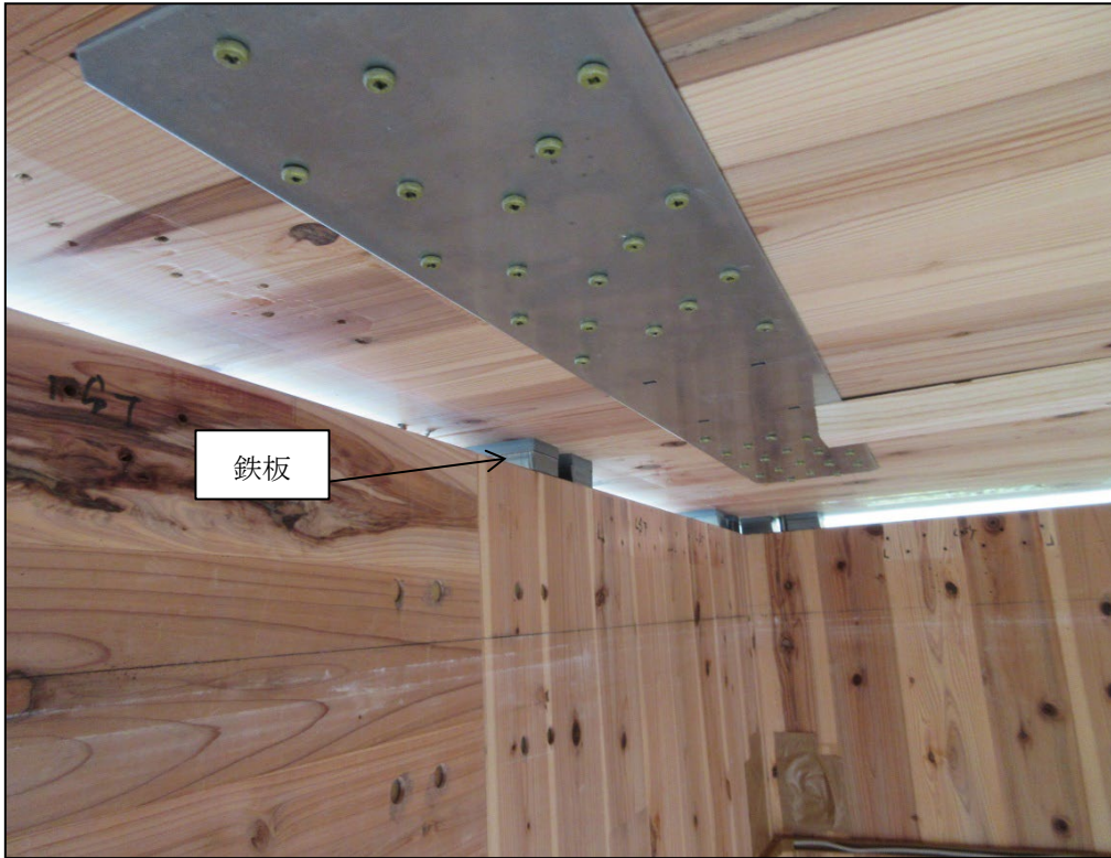
写真-2.2.26 鉄板厚 30mm の設置状況 (試験体 B5)
