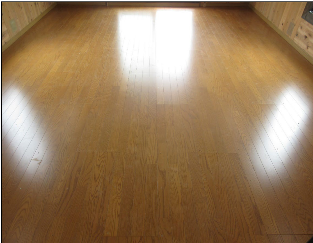
(8) 施工完了時（突板張り合板および幅木）
