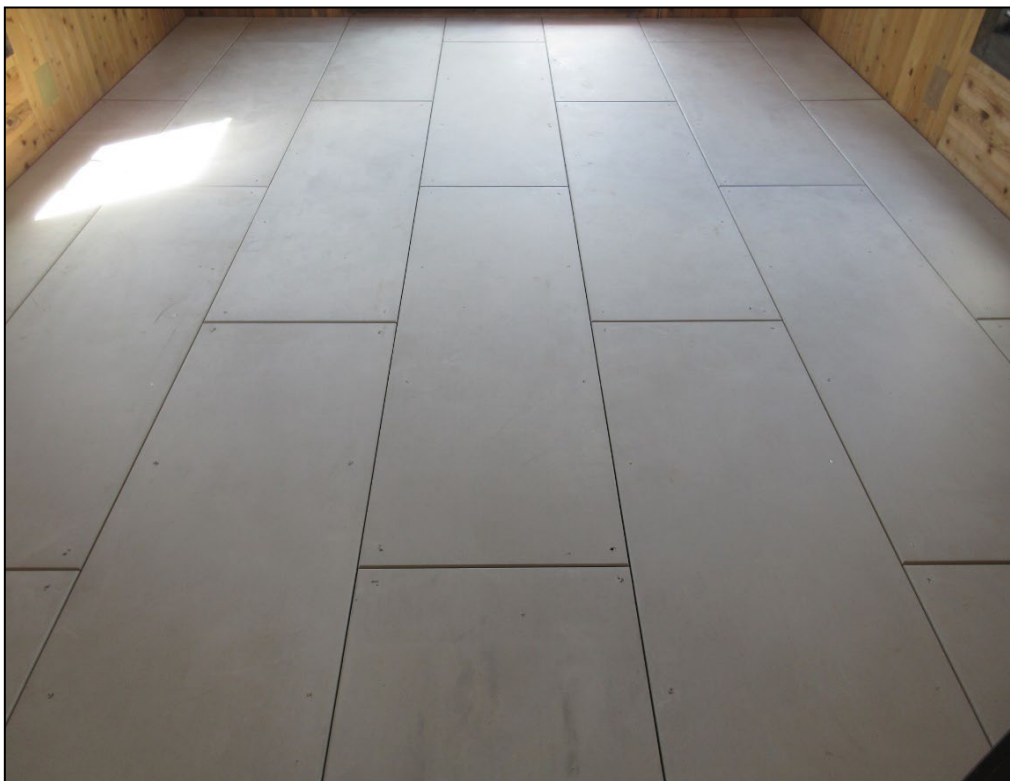
(6) 繊維混入押出成形セメント板
