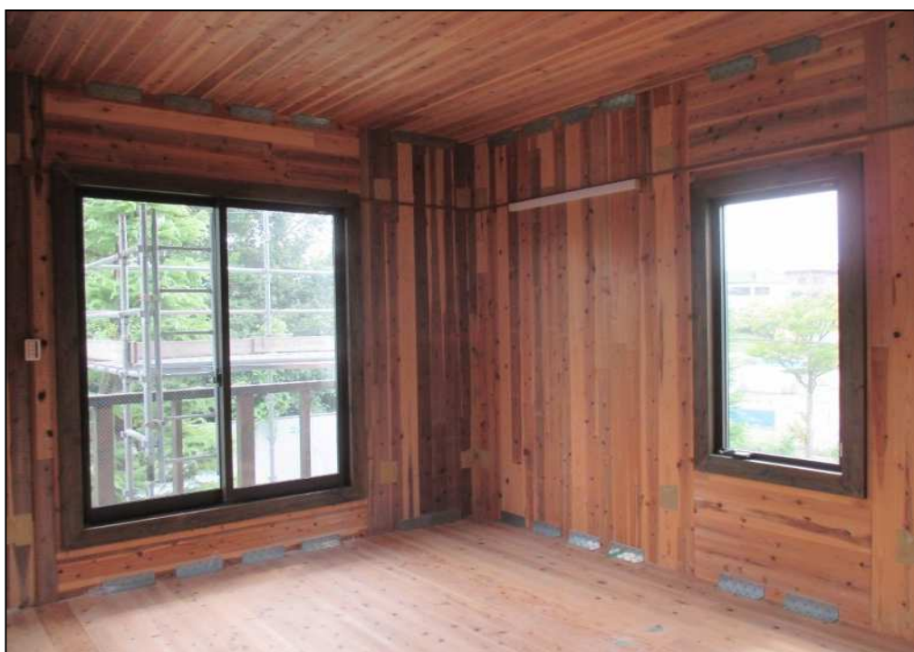
(d) 内観 (B棟2階: たてすべり出し窓と引き違い窓)
