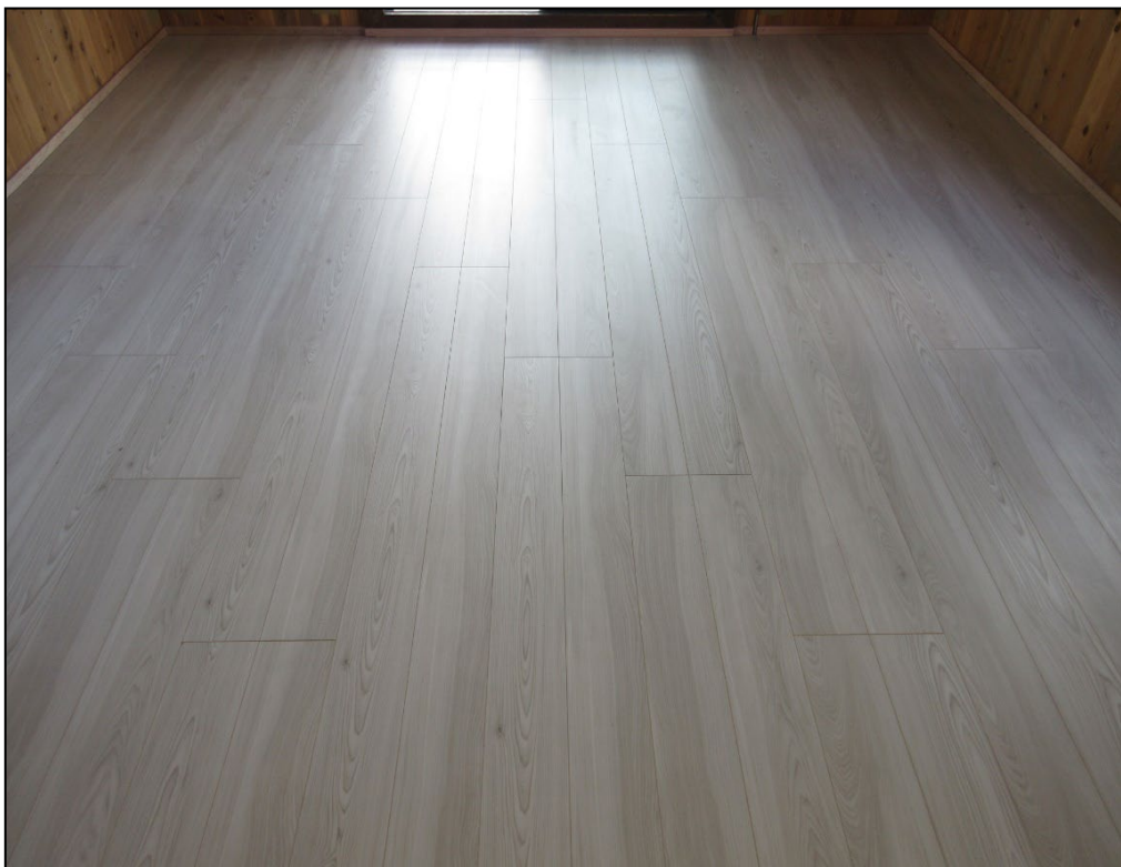
(8) 施工完了時（シート張りフローリングおよび幅木）
