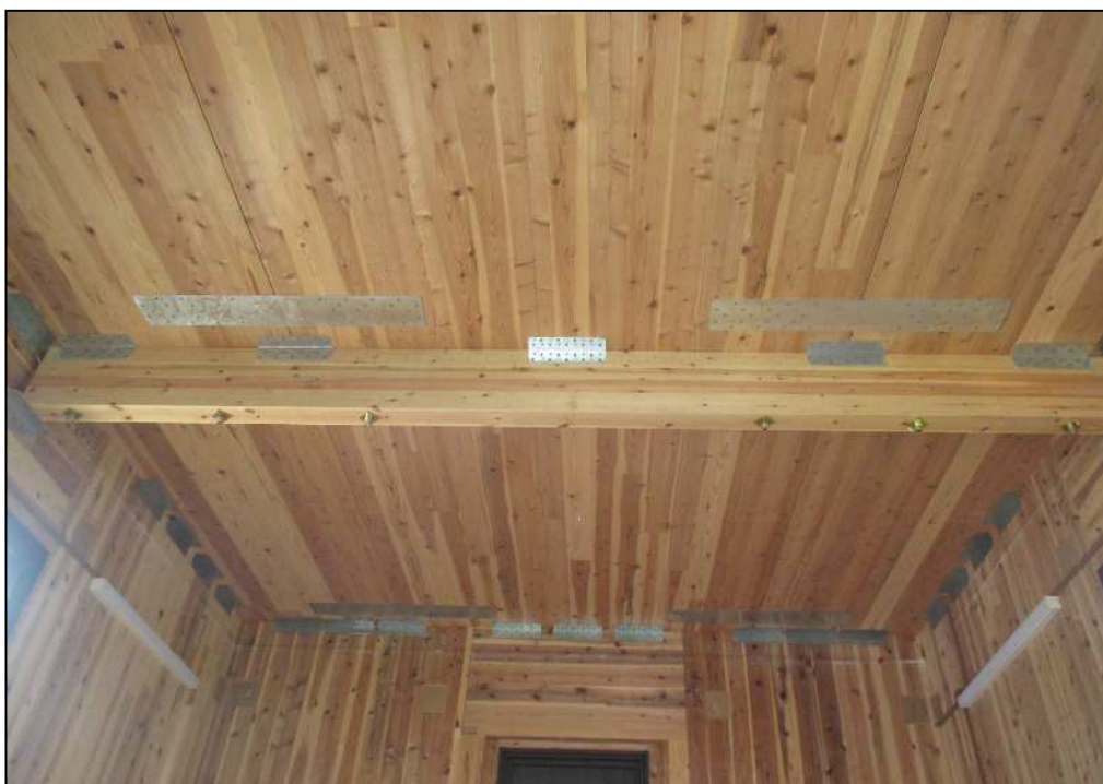
(b) 梁および補強金物
