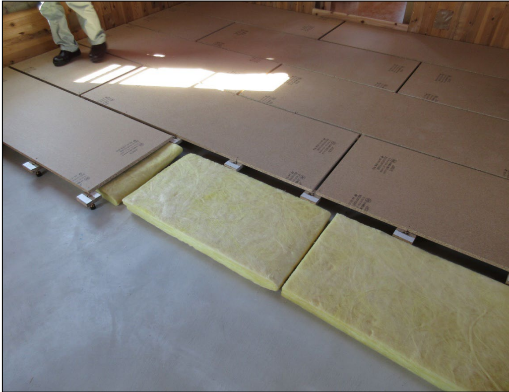
(1) パーティクルボード、床下グラスウール、支持脚、台座
