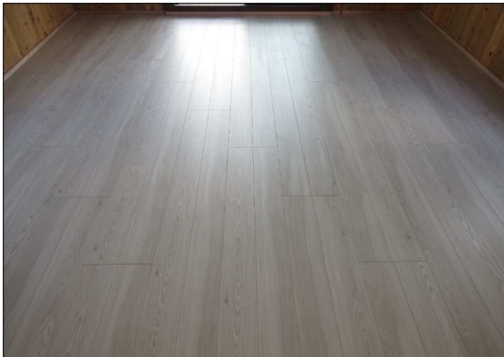
(k) シート張りフローリング (施工完了時)
