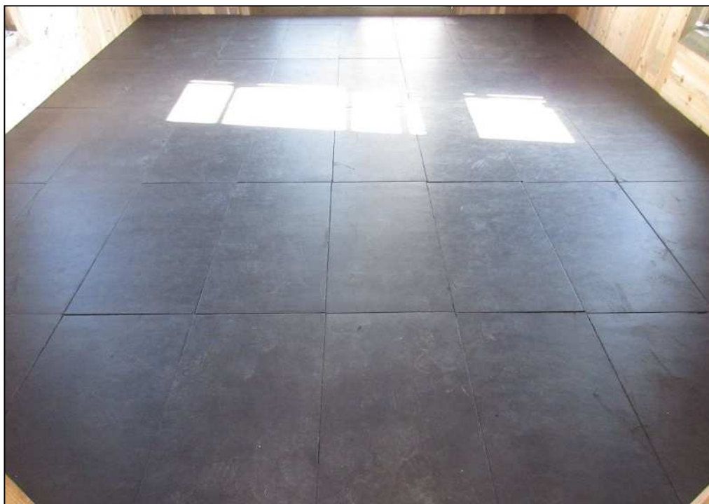
(c) アスファルト系制振マット
