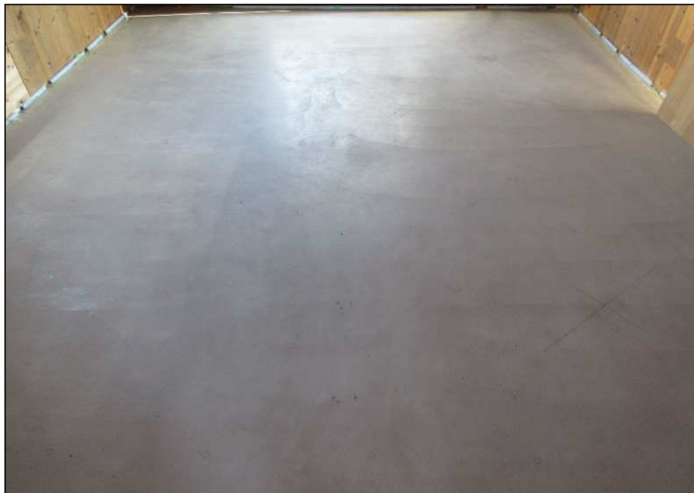
(a) コンクリート打設
