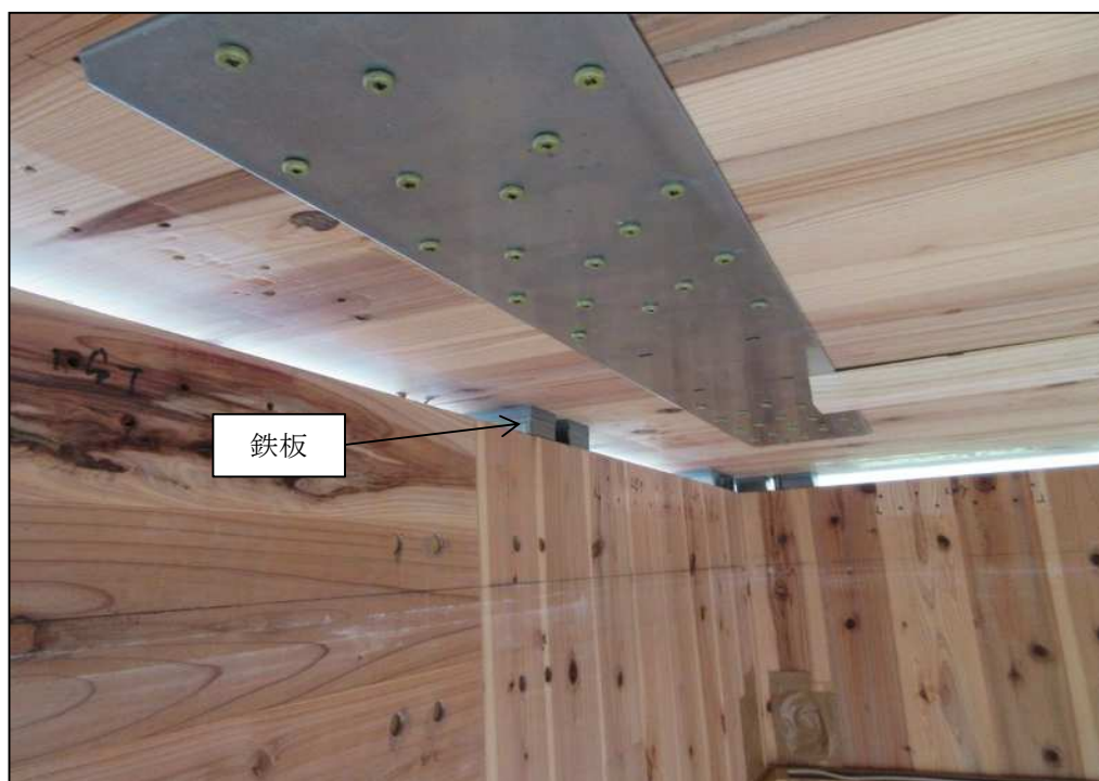
(b) 鉄板の設置状況
