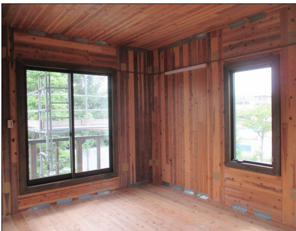
(4)内観（2階部分：CLT床素面の状態）
