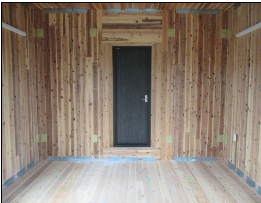
(3)内観（2階部分：A室B室間のドア）
