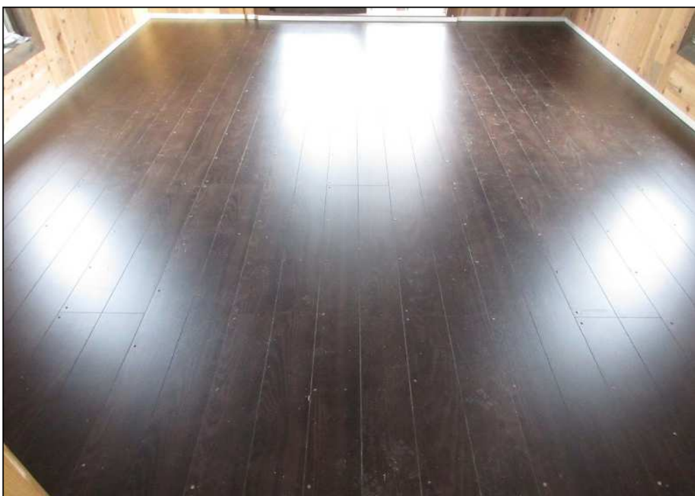
(f) 施工完了時
