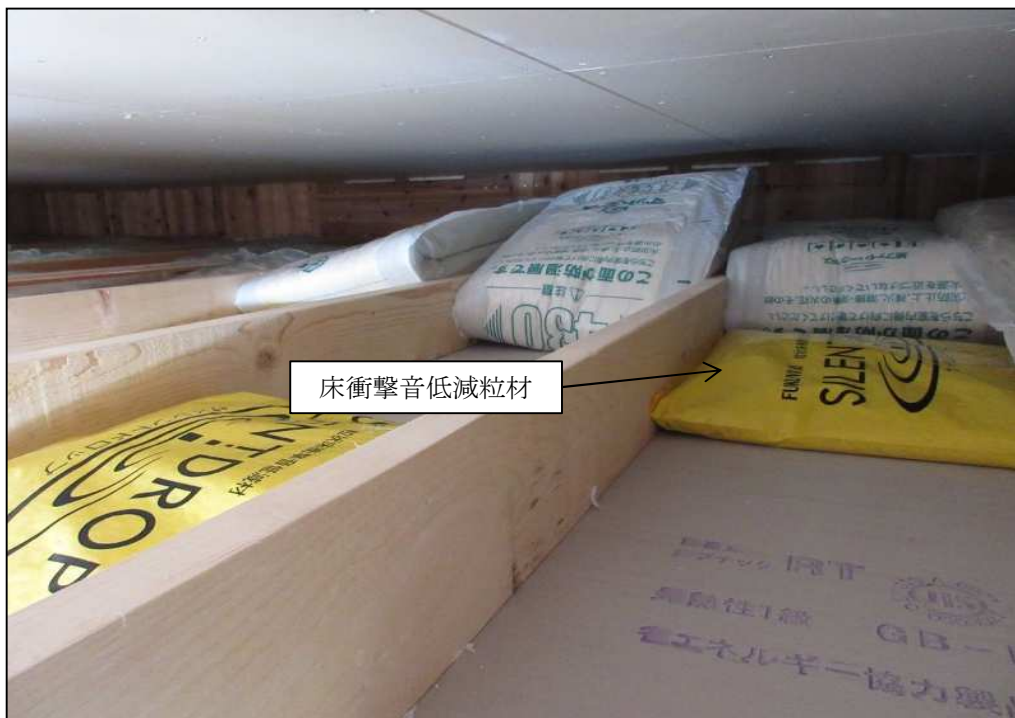
(d) 床衝撃音低減粒材およびグラスウール (二重天井C) ※撮影用にグラスウールを持ち上げている状態。
