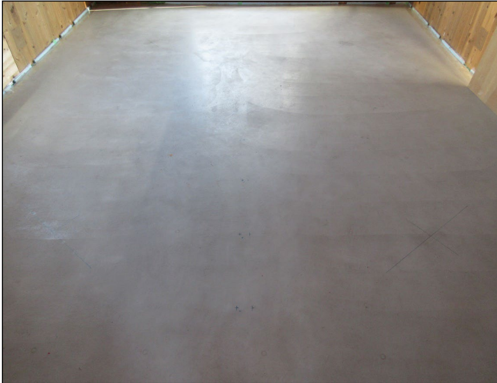
(1) B室2階床側（コンクリート打設あり）
