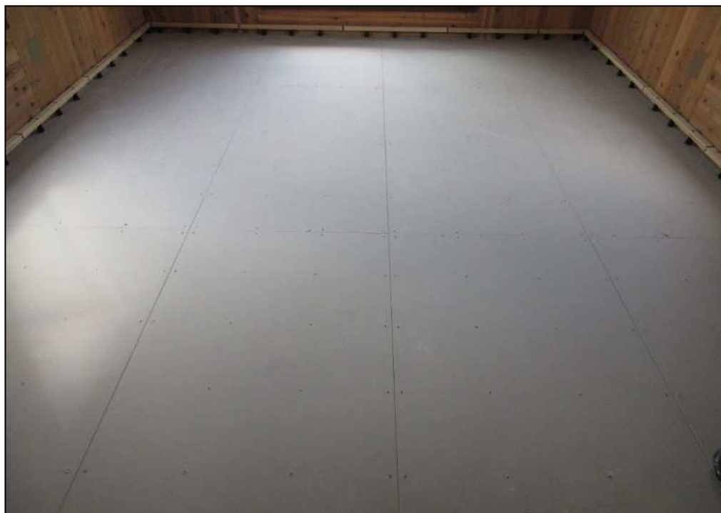
(a) 下地硬質せっこうボードおよび際根太
