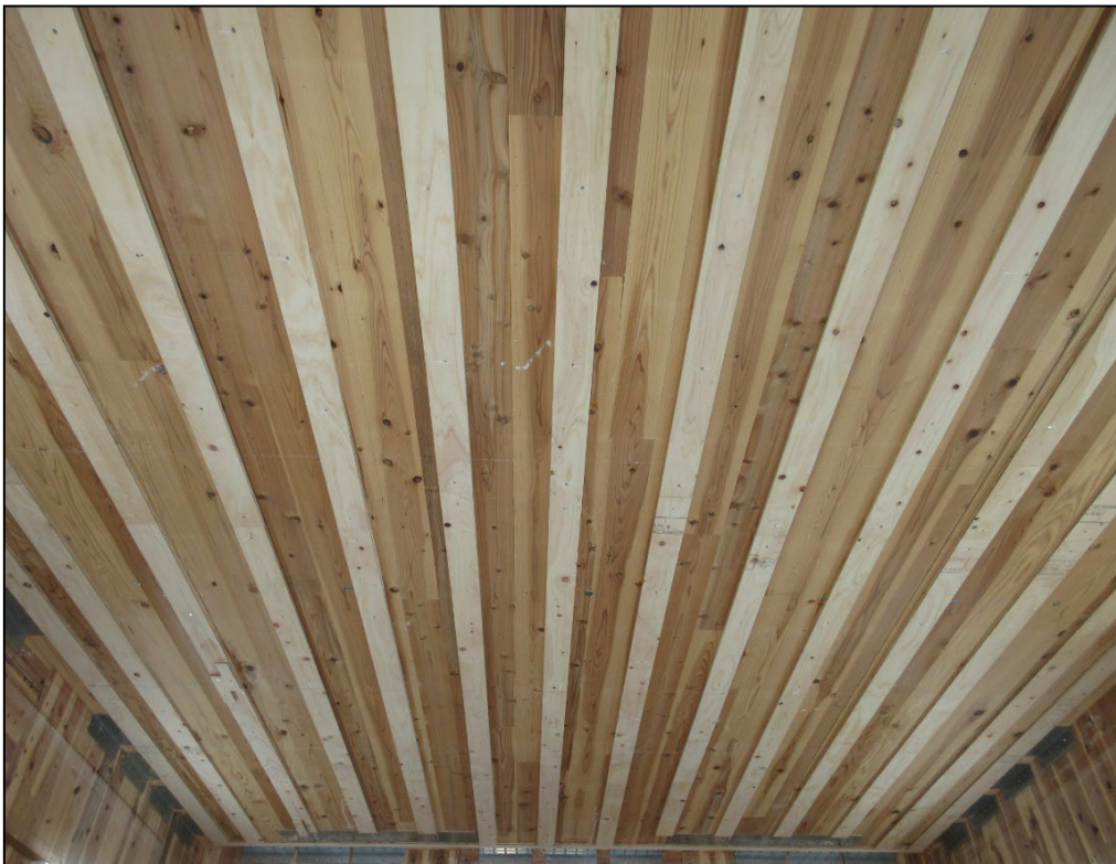
(4) 天井根太（1階天井側に施工）
