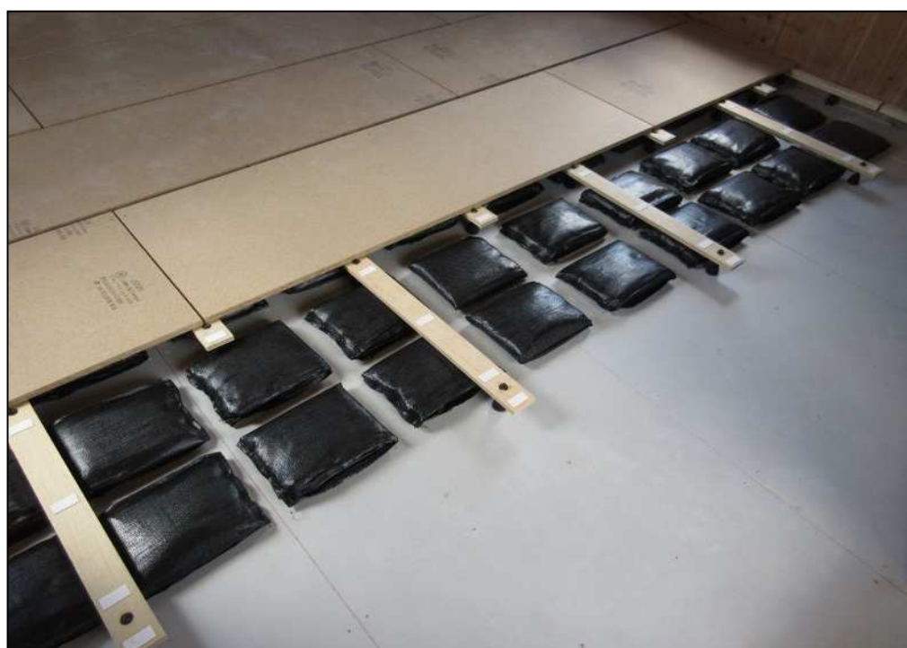
(b) パーティクルボードおよび床下制振材
