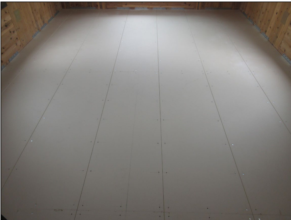
(2) 床上側下張り強化せっこうボード（2階床上に施工）
