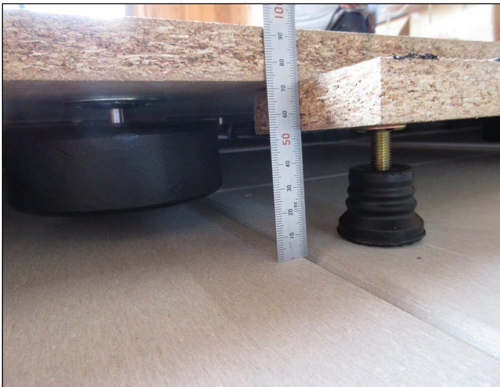
(2) 中央部の断面（支持脚、ダンパー、パーティクルボード1層目）
