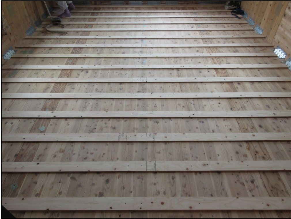
(1) 床根太（2階床上に施工）
