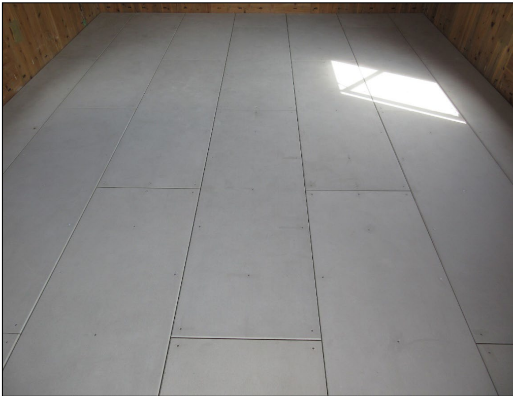
(2) 繊維混入押出成形セメント板
