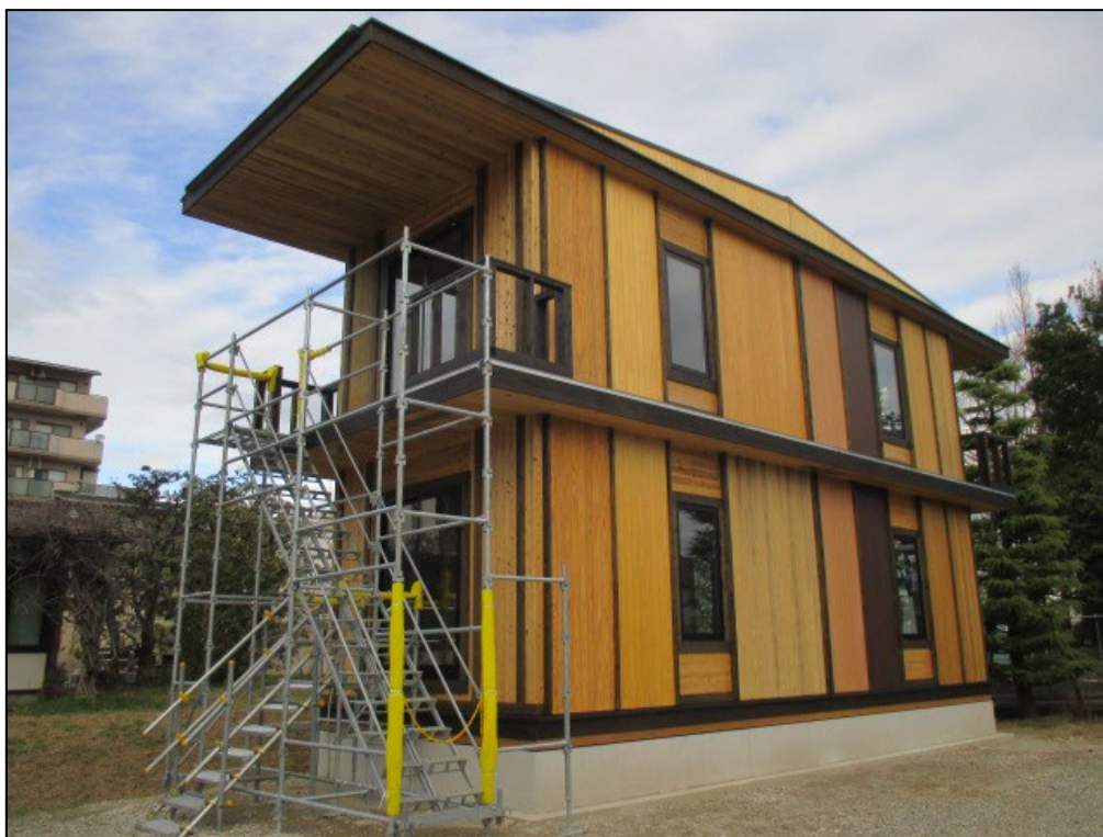
(1) 外観（南西側より）
