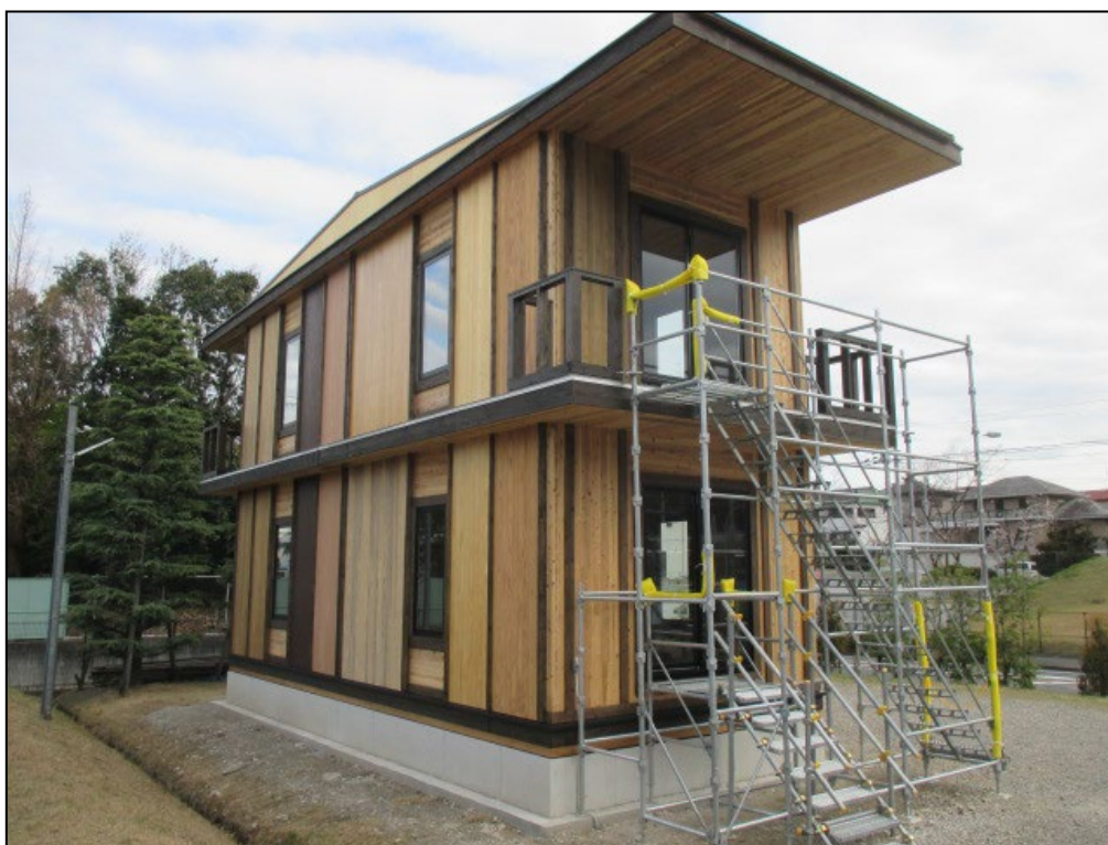
(2) 外観（北西側より）
