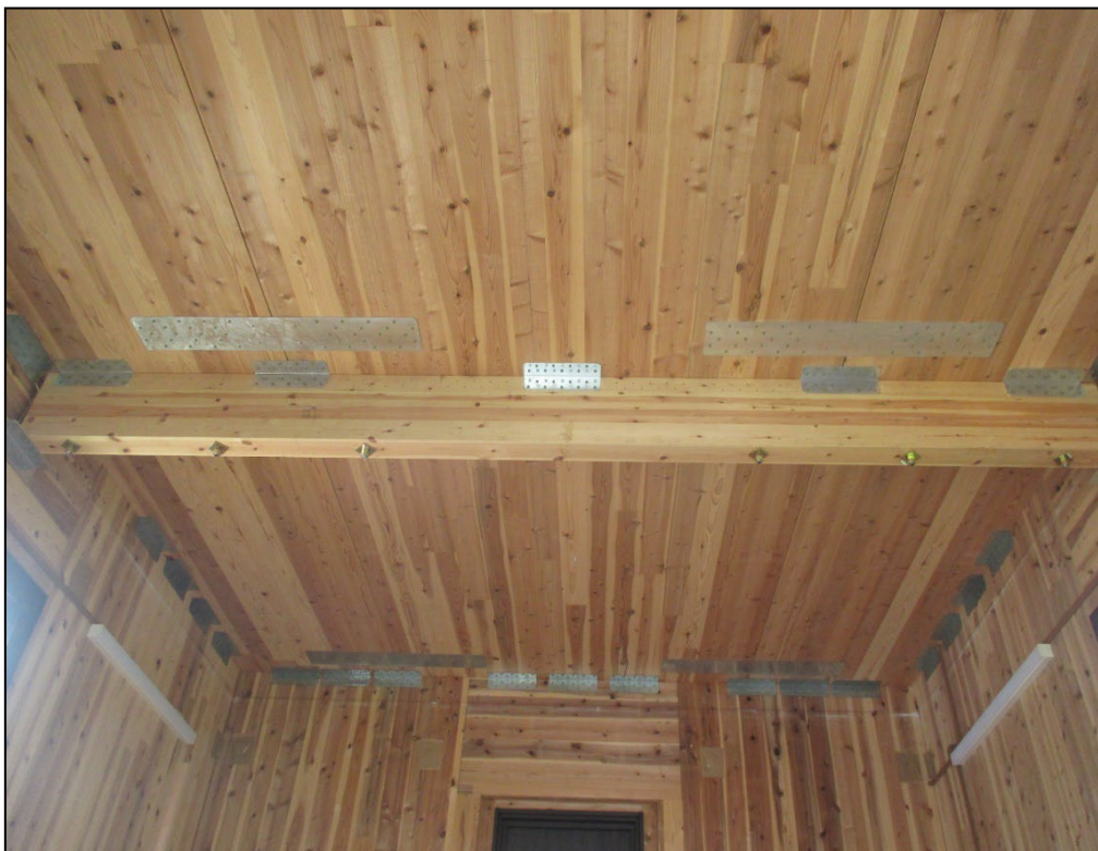
(2) B室1階天井側（梁および補強金物）
