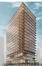
三井不動産と竹中工務店は、東京・日本橋に地上17階・高さ約70m、延床面積約26,000㎡となる木造賃貸オフィスビル計画の検討に着手したことを発表しました。これは現存する木造高層建築物としては国内で最大・最高層となるもので、構造材に使用する木材量も国内最大規模の1,000㎡超となる見込み。予定では2023年に着工し、2年後の2025年に竣工予定です。木材には三井不動産が北海道に保有している森林から活用し、森林資源と地域経済の好循環を図っていくとしています。また、竹中工務店が開発を進めてきたCLTなど木材の耐火技術や耐震技術を導入。これらにより同規模の5造オフィスビルに比べて、建築時のCO<sub>2</sub>排出量を約20%削減すると見込まれています。
