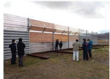
写真 5.1-45 CLT 防雪柵試験施工現場
