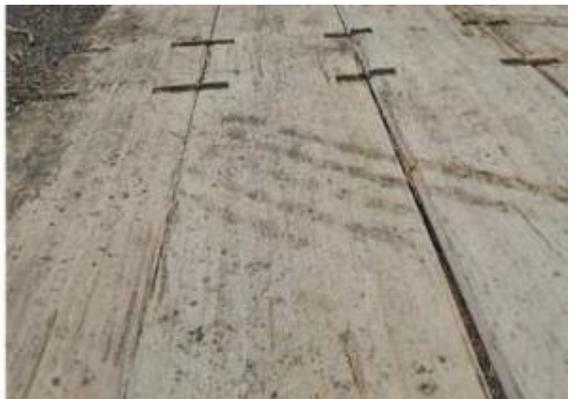
写真 5.1-28 重機による CLT 敷板表面の損傷
