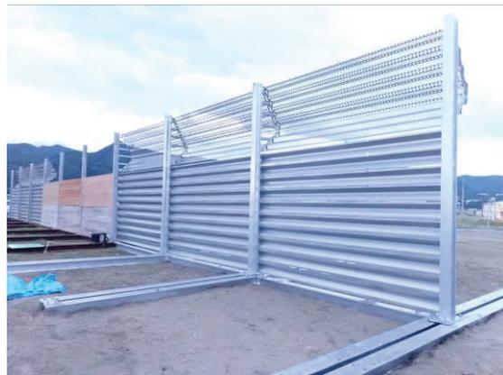
写真 5.2-8 設置した鋼製防雪柵
