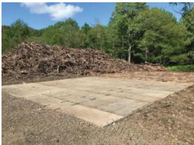
写真 5.1-23 敷設当時の CLT 敷板の様子
