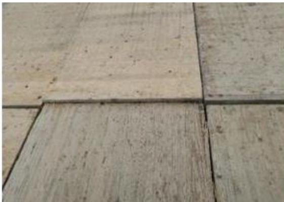
写真 5.1-27 CLT 敷板の段差
