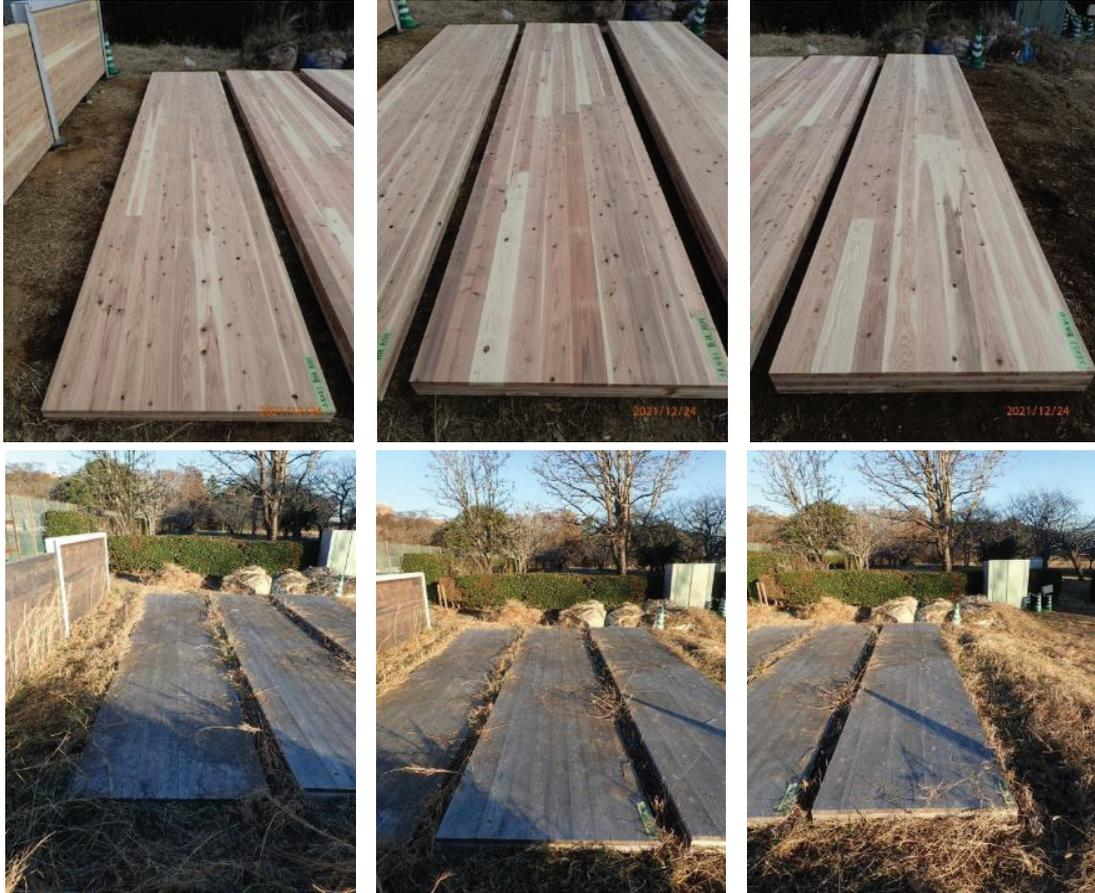
写真 5.4-2 CLT 敷板の設置状況(つくば市)
