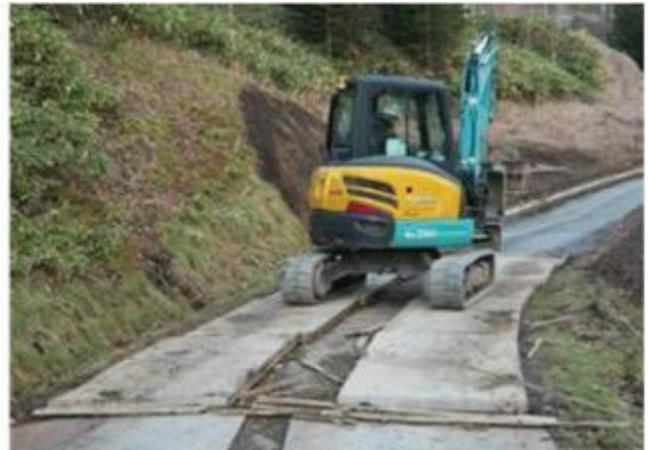
写真 5.3-34 CLT 敷板上を重機が走行する様子
