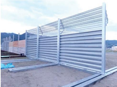
写真 1.4-2 新設した鋼製防雪柵(左奥:CLT 防雪柵)
