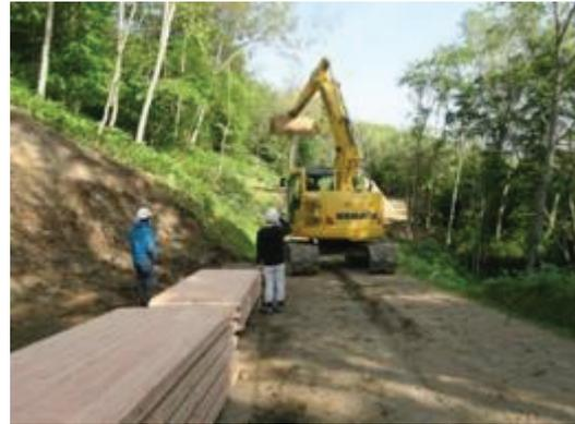
写真 5.1-30 バックホーによる敷設作業
