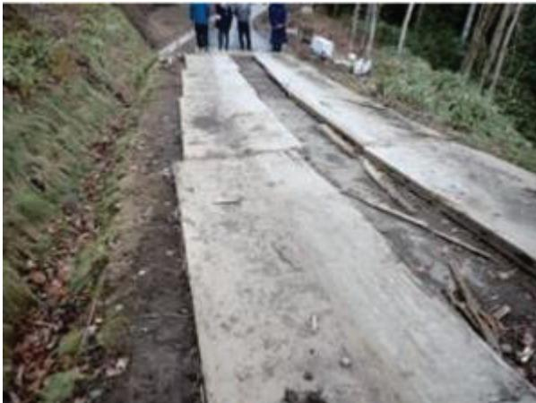
写真 5.3-33 レイアウト変更後の CLT 敷板
