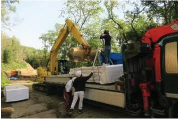
写真 5.1-29 カラマツ製 CLT 敷板の搬入
