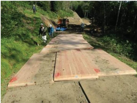
写真 5.1-31 敷設後の CLT 敷板
