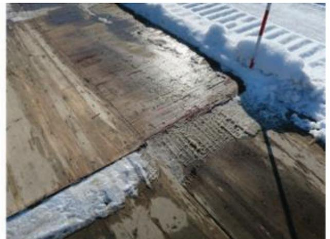
写真 5.1-18 CLT 敷板の段差箇所
