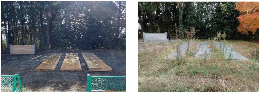
写真 5.4-3 CLT 敷板の設置状況(熊本市)
