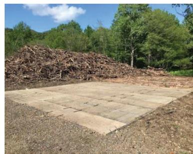
写真 1.4-1 CLT 敷板敷設状況の例(左:治山工事現場の例、右:チップ生産ヤードの例)
