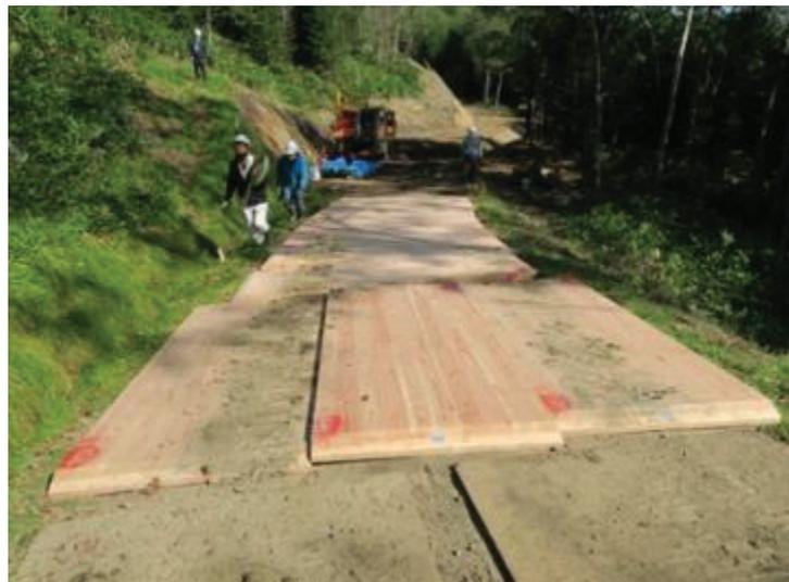
写真 5.1-6 CLT 敷板設置場所
