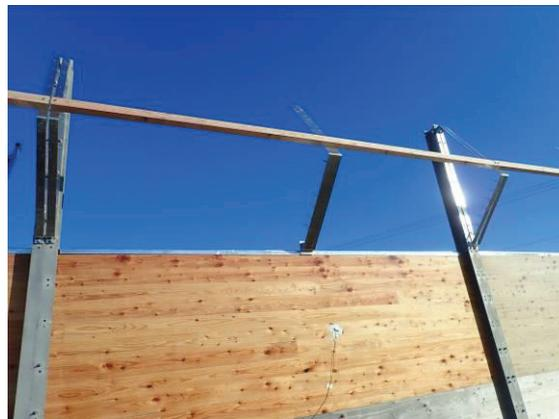
写真 5.2-2 鋼製部材を設置した状況
