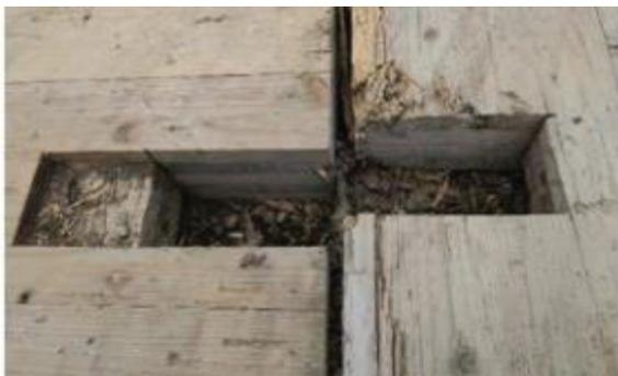
写真 5.1-25 吊り具を挿入する欠き込み
