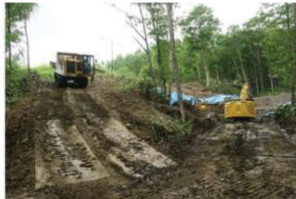
写真 5.1-8 左:バックホーが採石を積み込む様子、右:クローラードンプが車路を走行する様子
