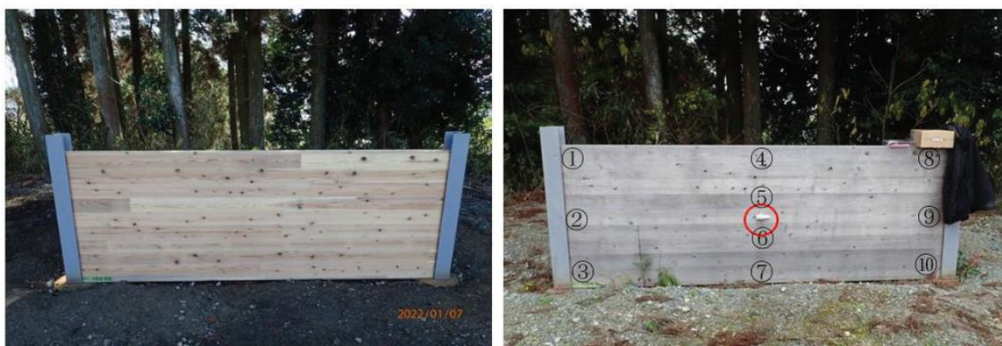
写真 5.4-7 CLT 防護柵(熊本市)
