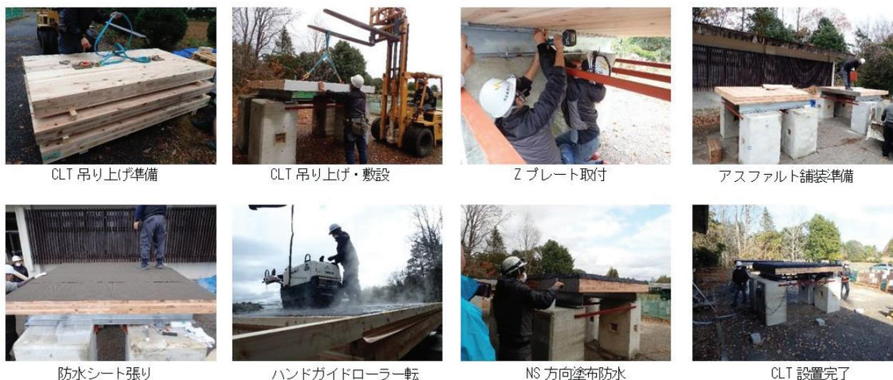
写真 4.2-1 CLT 設置状況
