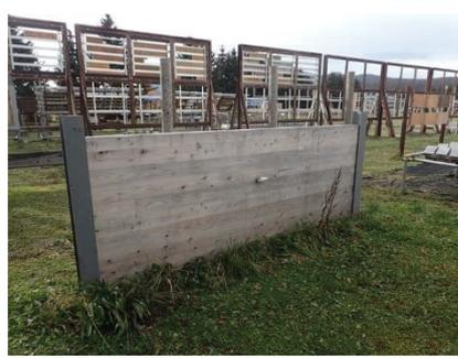
写真 5.4-5 CLT 防護柵(旭川市)
