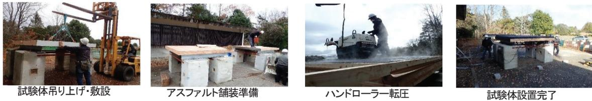
写真 1.3-1 試験体設置状況
