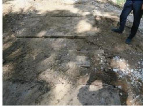
右:表面の損傷が激しい CLT 敷板
