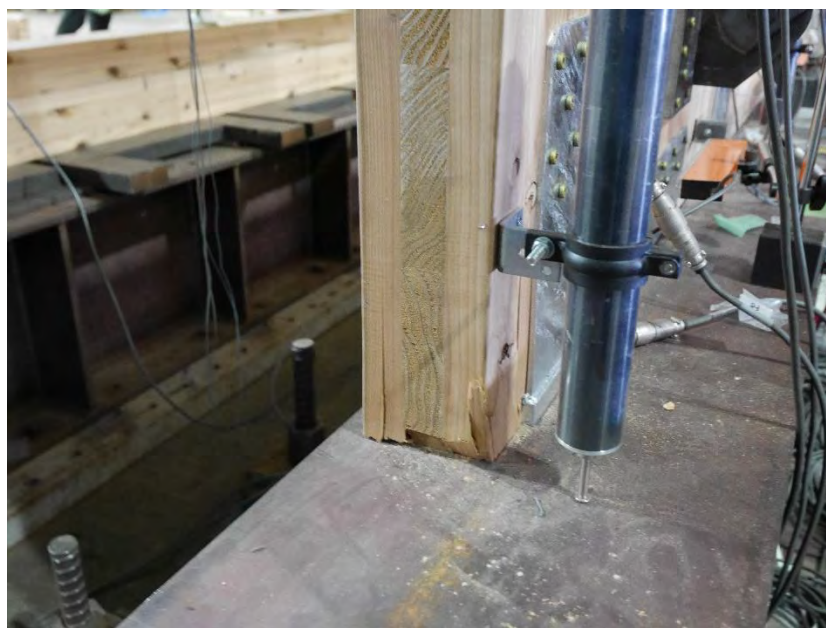
図 3.4.4-2 壁脚端部の支圧変形
