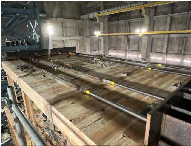
RF 施工状況
