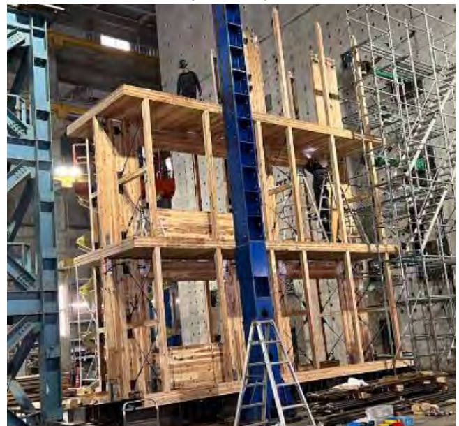
3F 柱・壁パネル組立
