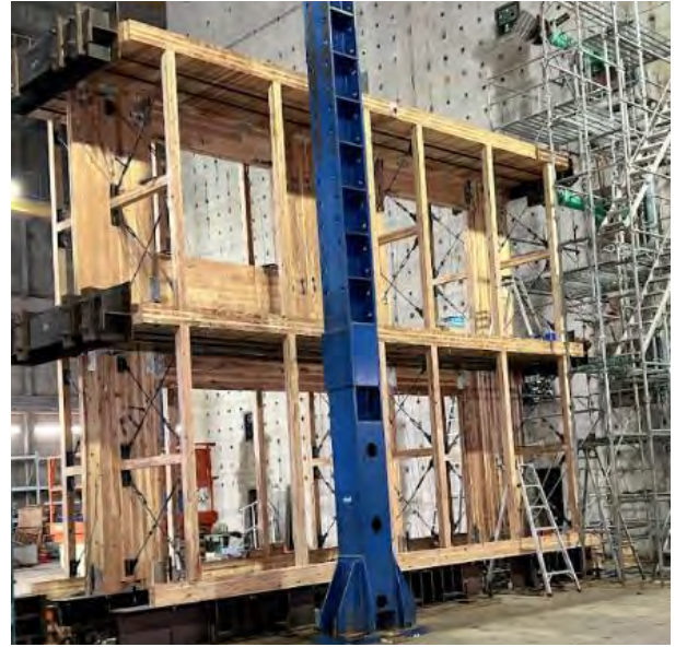
2F ブレース取り付け
