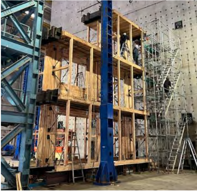
加力桁取り付け
