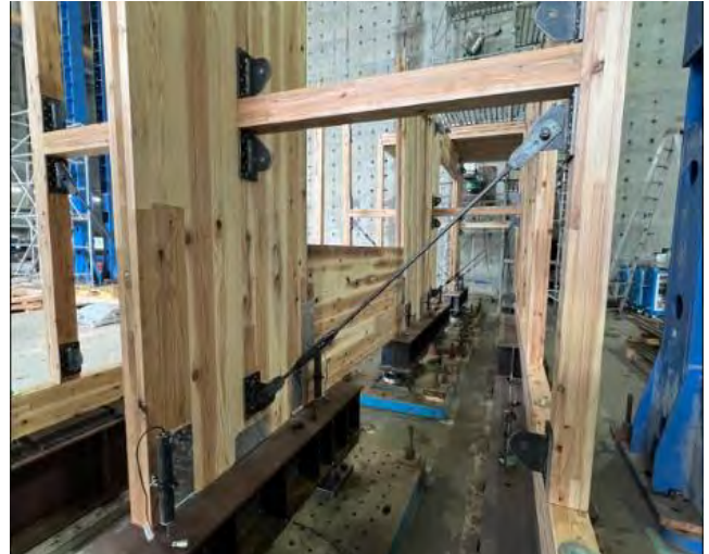
1F ブレース取り付け
