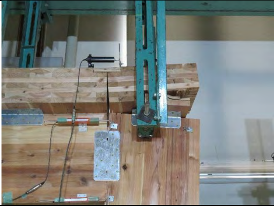
+1/15rad 時 床端部の脱落
