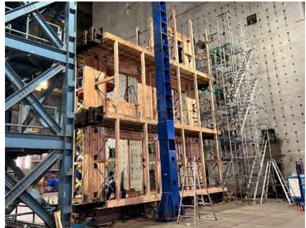
3F 柱・壁パネル組立
