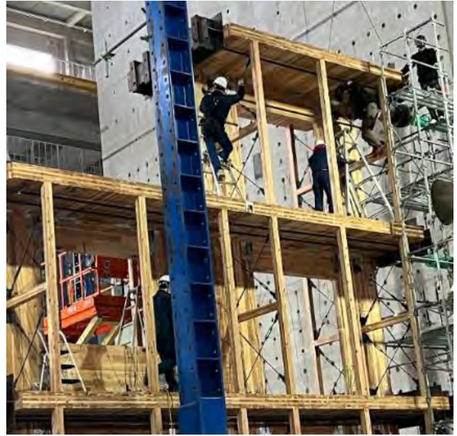
加力桁取り付け
