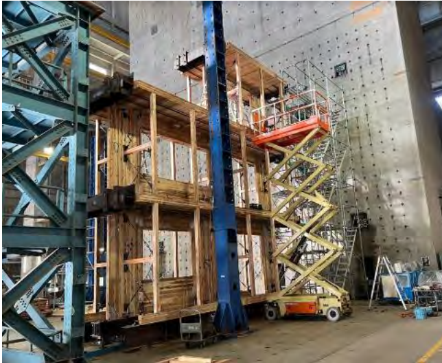
3F 床パネル組立・加力桁取り付け
