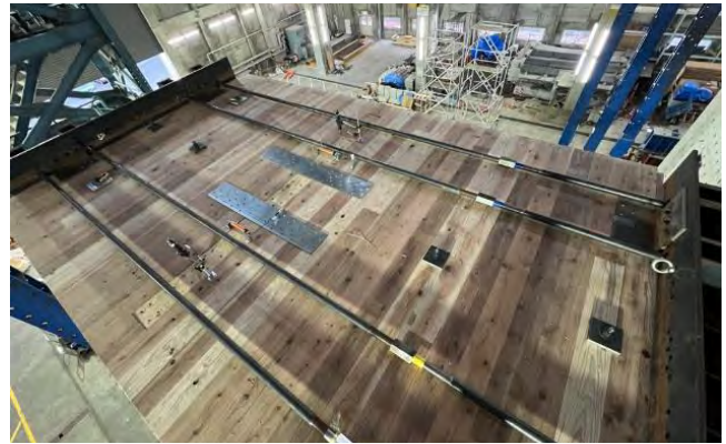
RF ケーブル接続
