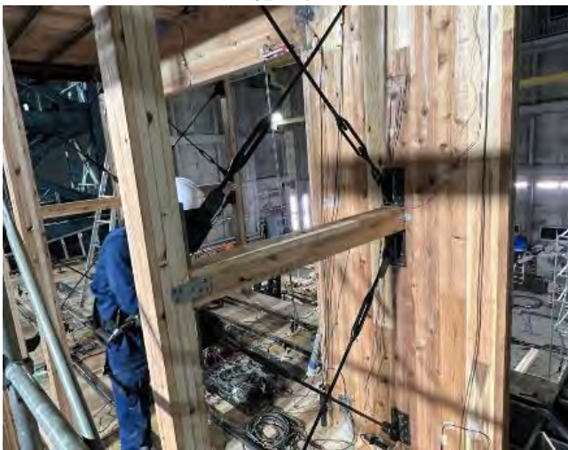
3F 施工状況
