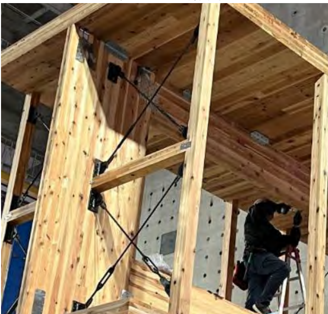
2F ブレース取り付け
