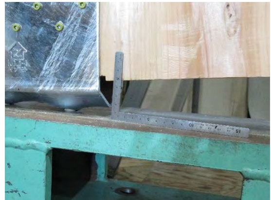
+1/10rad時 せん断金物の変形
