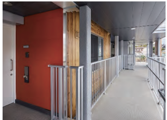
全戸床段差をなくしたバリアフリーのエントランス
