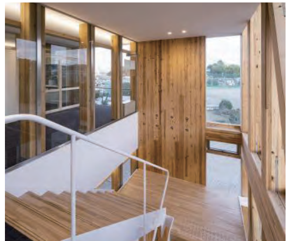
3階分通した壁のCLTが現しになった階段室
