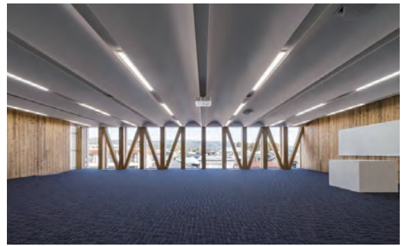
CLTが2面現しとなっている、やわらかな印象の教室
