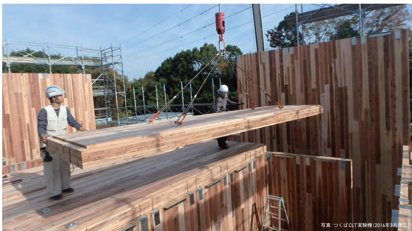
現在、国内で製造可能な最大のCLTパネル(幅3m×長さ12m、銘建工業)
