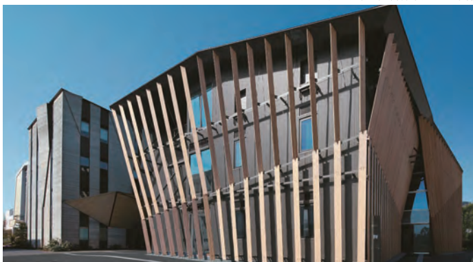
外壁部分には、スギ集成材のルーバーを角度を変えて設置
