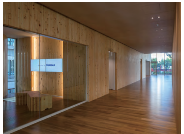
1階エントランスロビー。壁全面のCLTを現しで内装仕上げ
