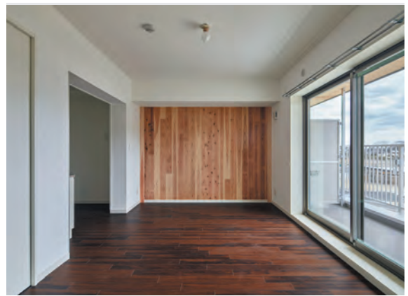
準耐火構造の燃えしろ設計により表としたCLT壁。躯体と仕上げを兼ねる
