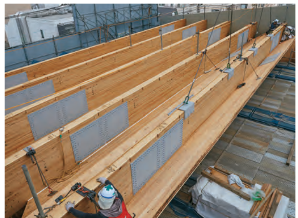
長さ方向は現場接合とし、CLT折板構造で17mのスパンを実現
