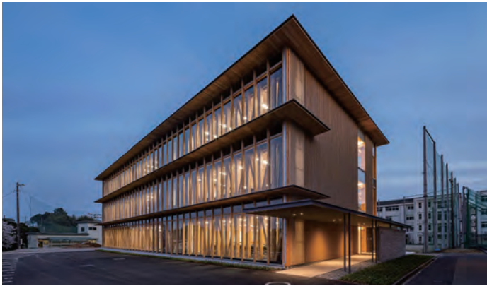
間方向にはCLTを3階分通した壁を配置、桁行方向は軸組工法
