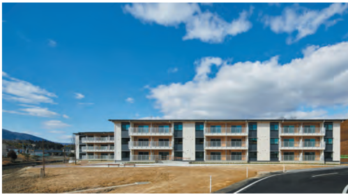
大版CLTパネルが得意とする箱型の建物形態と繰り返しの立面計画
