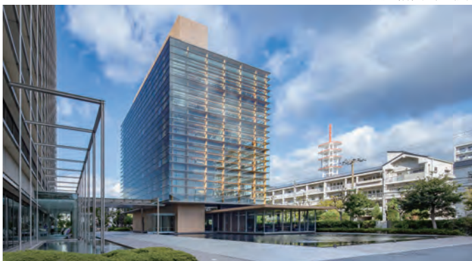
東から見た外観。2~6階の外周全体を覆うダブルスキンの外皮
