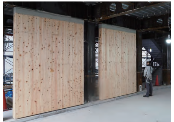
1階から6階まで続くコアの鉄骨フレームにCLTを耐震要素として設置
