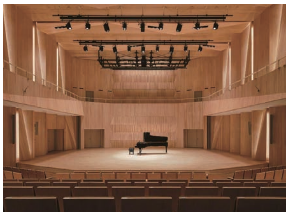
現して使用したCLTは、構造だけではなく音響反射としても寄与
