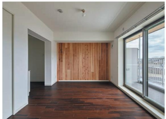
準耐火構造の燃えしろ設計により表としたCLT壁。躯体と仕上げを兼ねる
