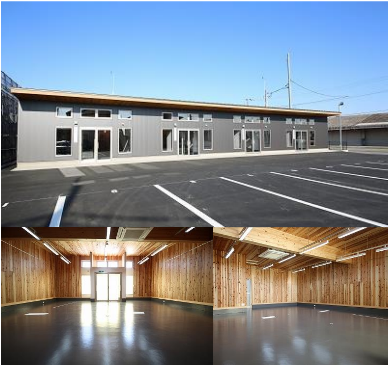
写真提供：藤崎建設工業(株)
