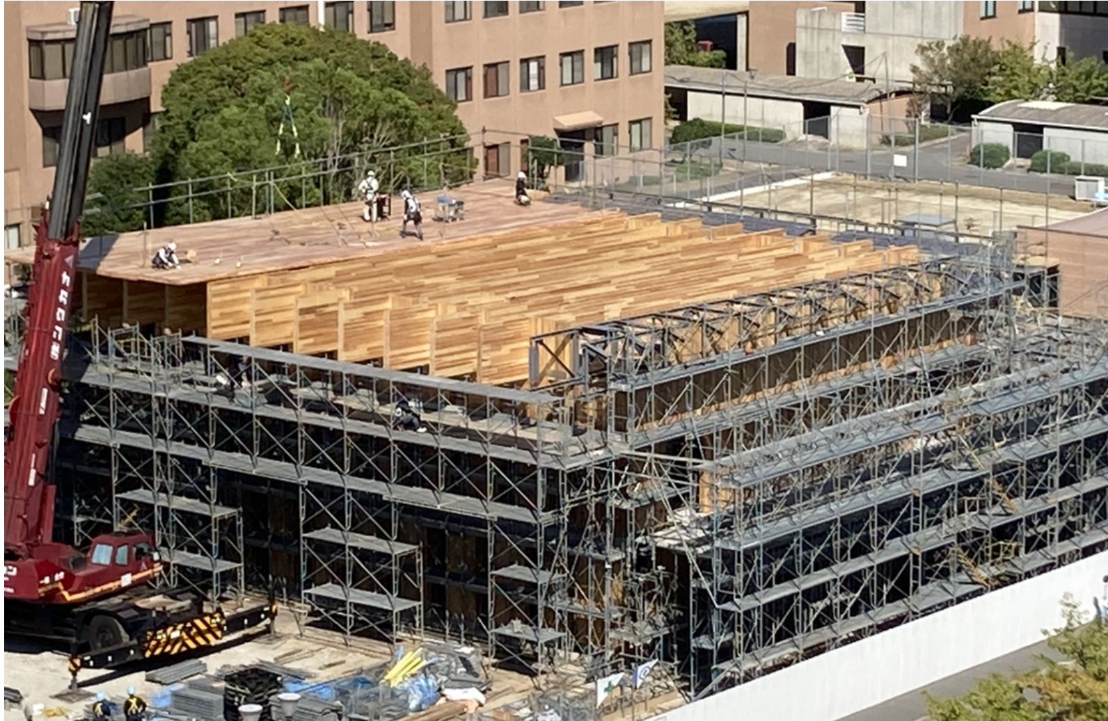
岡山大学 共育共創commons建設状況
