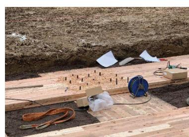
写真 5.1-4 丸鋼での固定 (CASE 2)
