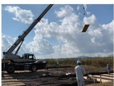
写真 5.1-3 CLT の吊り上げ、敷設
