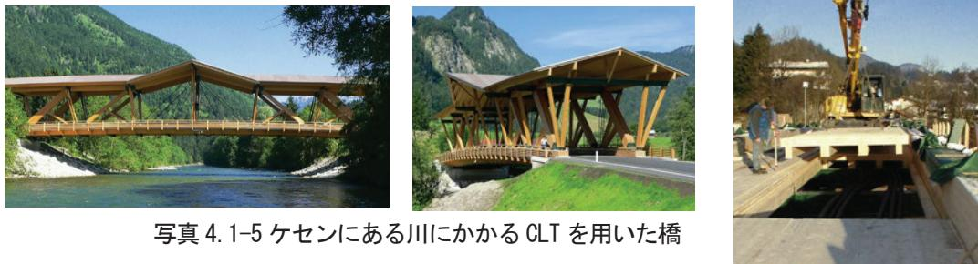
写真 4.1-5 ケセンにある川にかかる CLT を用いた橋
