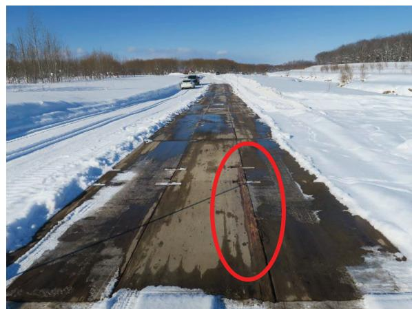
写真 5.3-7 CLT の損傷（運搬路）
