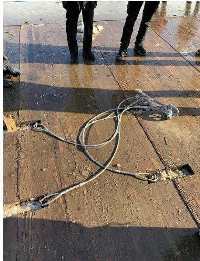
写真 5.3-6 CLT敷板吊り金具
