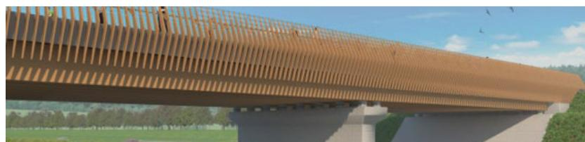
図 4.1-4 CLT を用いた建設予定の橋
