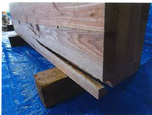
南面 東側（拡大）
