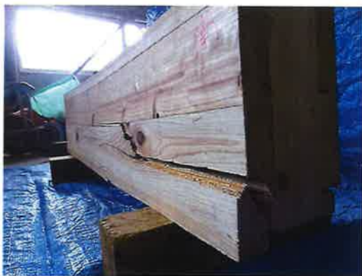
南面 東側（拡大）
