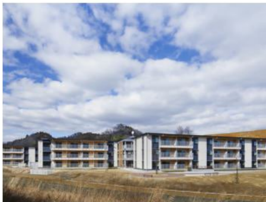
復興公営住宅北沢又団地
