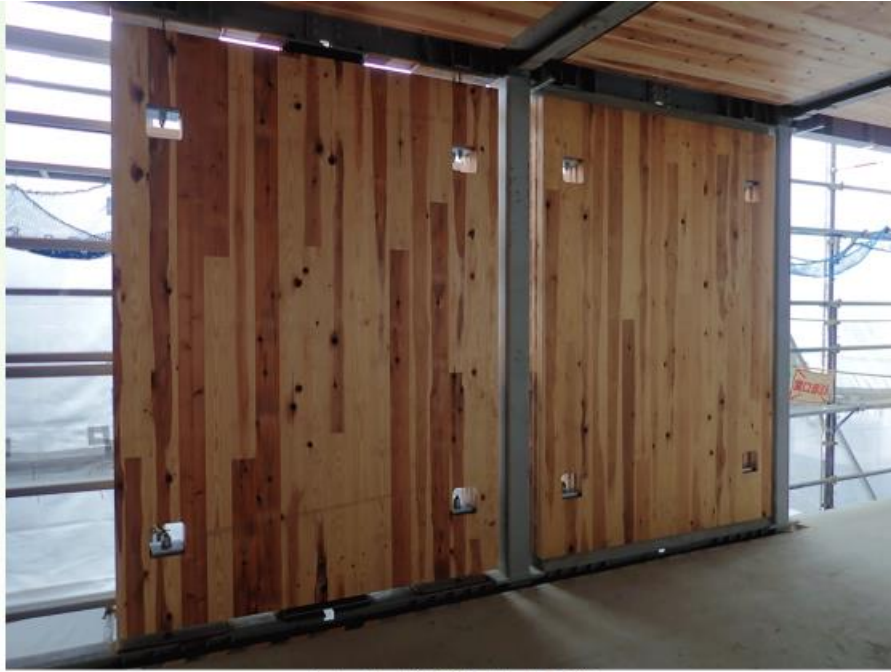
水平力だけ負担する壁 兵庫県林業会館（写真提供：㈱竹中工務店）
