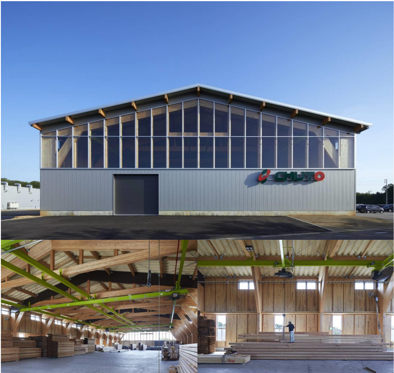
写真提供：(株)梶谷建設
