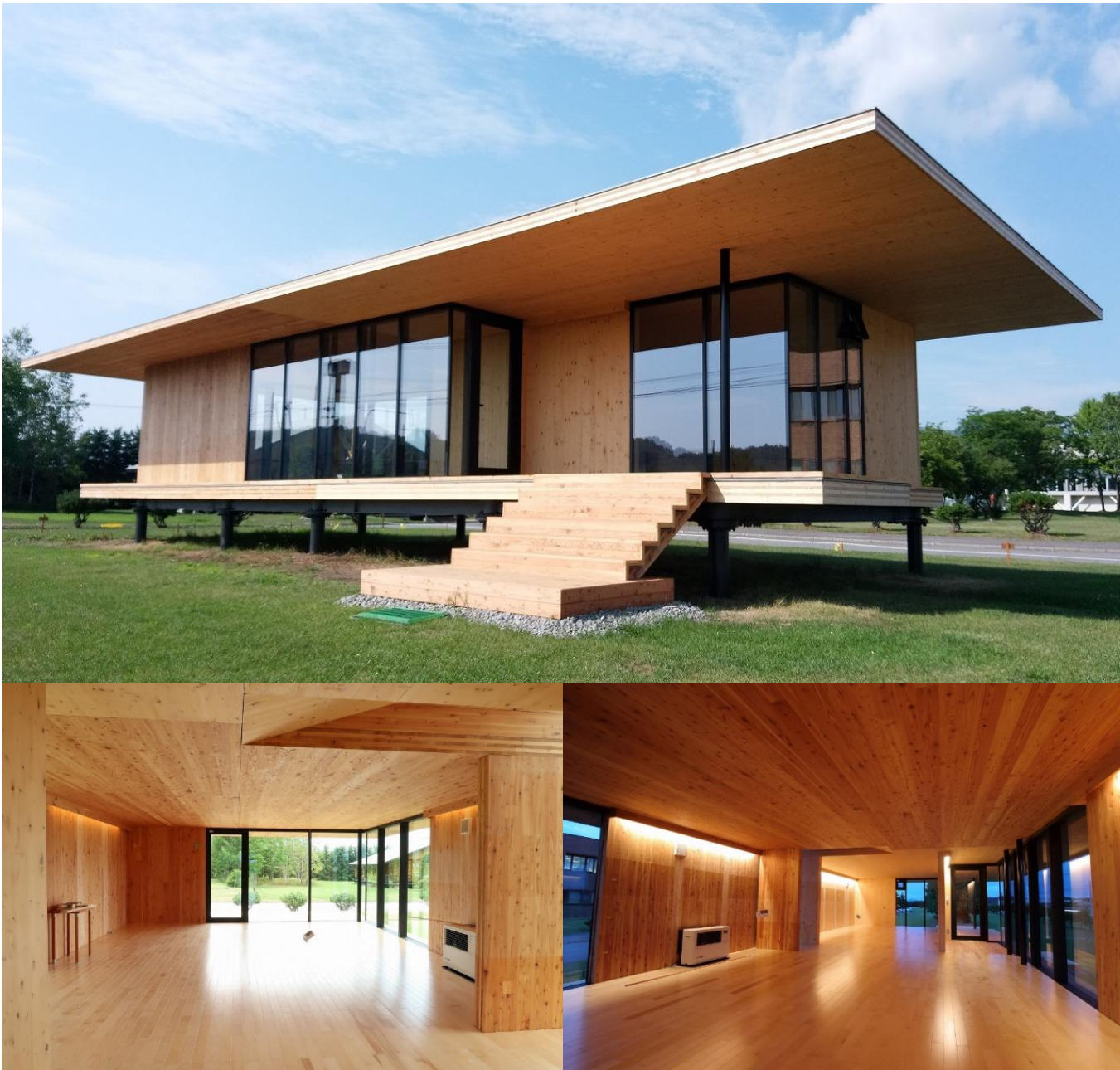
写真撮影：北海道総研・林産試験場
