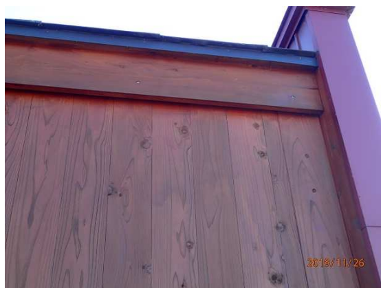
破風・外壁上部
