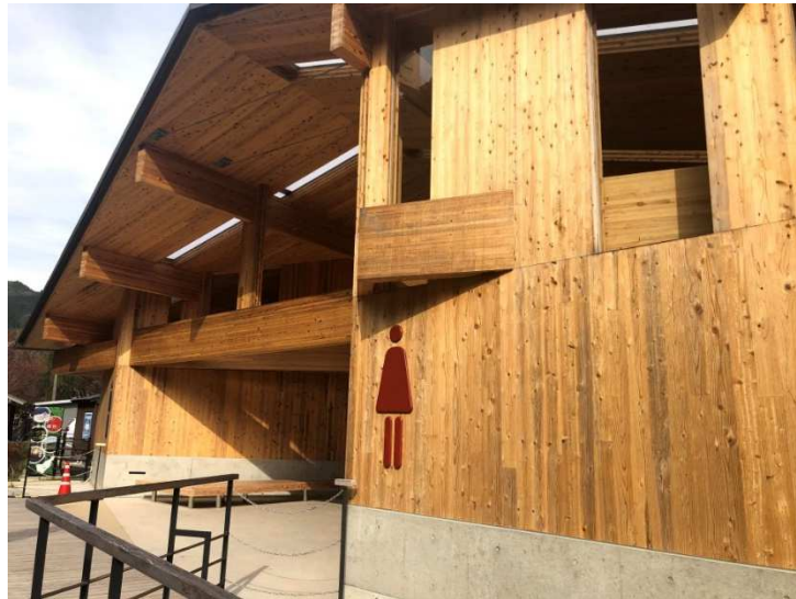
写真 12 : 川に面した西側外壁
