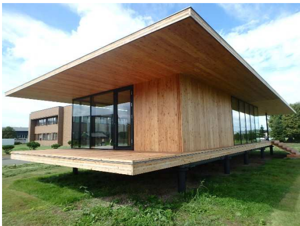
写真 1 :外壁・軒裏CLT使用事例
