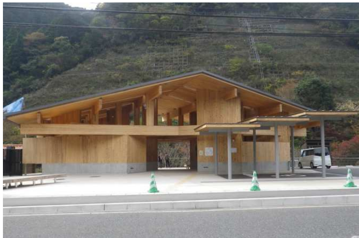
写真 13 : 道路に面した東側外壁
