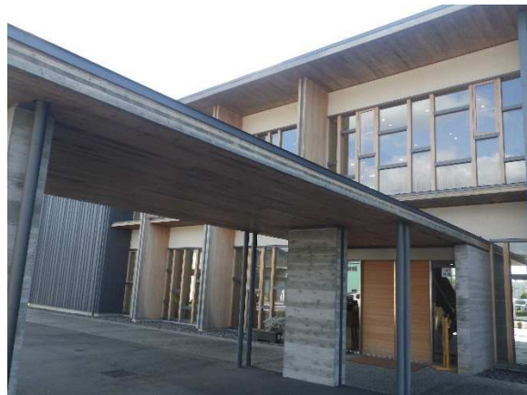
北側エントランスキャノピー
