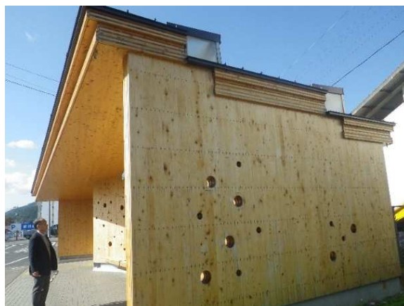
東側外壁(板カバー取付、屋根段差)
