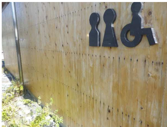
西側壁(鉄釘サビ、塗装変化)
