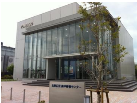
写真 1 5 吉野石膏神戸研修センター (CLT 建築物ではない) 外観 (兵庫会場)
