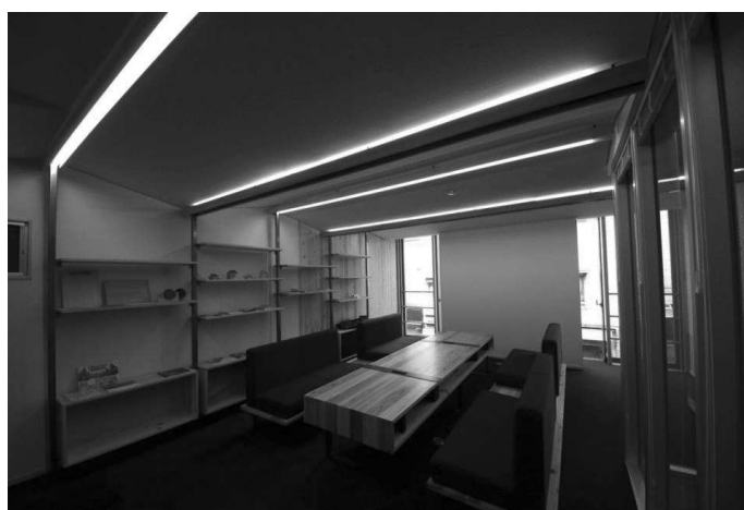
写真：部分的に配置した水平力を負担する CLT 壁パネルを現しとした設計例（高知の商業ビル）
