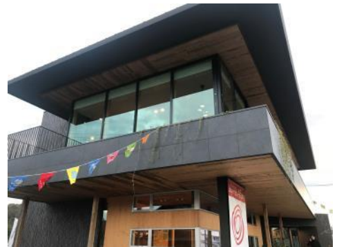
写真 22 軒天現しによる外装利用 （岡山会場）
