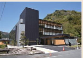
旧庁舎を用途変更し図書館にリノベーションした建物のバイオマスボイラー棟をCLTパネル工法にて建設。
