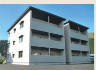
国土交通大臣認定を取得し建設されたCLTパネル工法3階建て共同住宅。駐輪場もCLT現しとしている。
