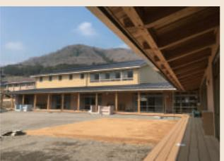
大断面集成材ラーメン架構+CLT耐震壁の小学校とCLTパネル工法+在来床組工法を組み合わせたこども園。
