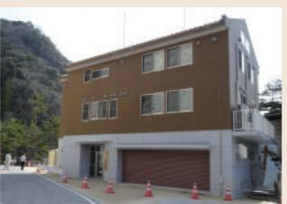
農林水産省として初めてCLTパネル工法を活用した1階(RC造)、2~3階(CLTパネル工法)のダム管理事務所。
