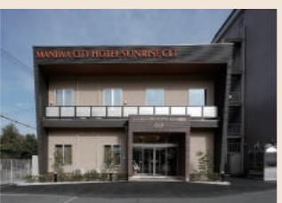
木造軸組工法の壁・床・屋根にCLTを使用した2階建ホテル。内壁・階段・2階床がCLT現しとなっている。
