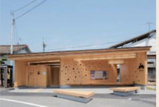
「3枚の壁」で、「3m×12m の3枚の屋根版」を支えるシンプルで合理的な構造で、CLTを現しとしている。
