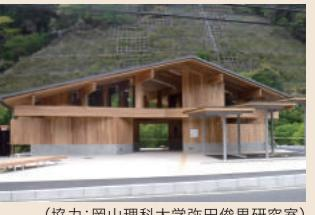
CLT建築の可能性を広げるため、多角形の平面形状で構成した魅力的な公衆トイレ。CLTパネル工法。
