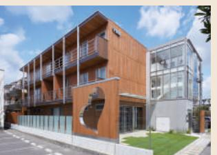
『全館内部CLT現し』日本初3階建てCLTパネル工法1時間準耐火燃えしろ設計による新入社員宿泊施設。
