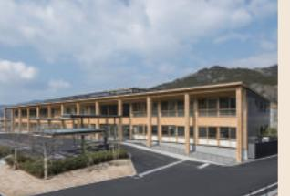
210mm角の一般製材を4本束ねた列柱による力強いメインファサードと吹き抜け空間「おちあいの杜」が特徴。
