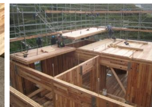
CLTを用いた施工例
