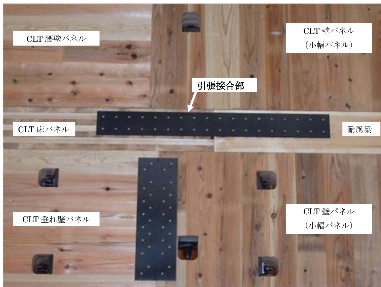
写真 2.2.4-2 耐風梁-床パネル間引張接合部の例
