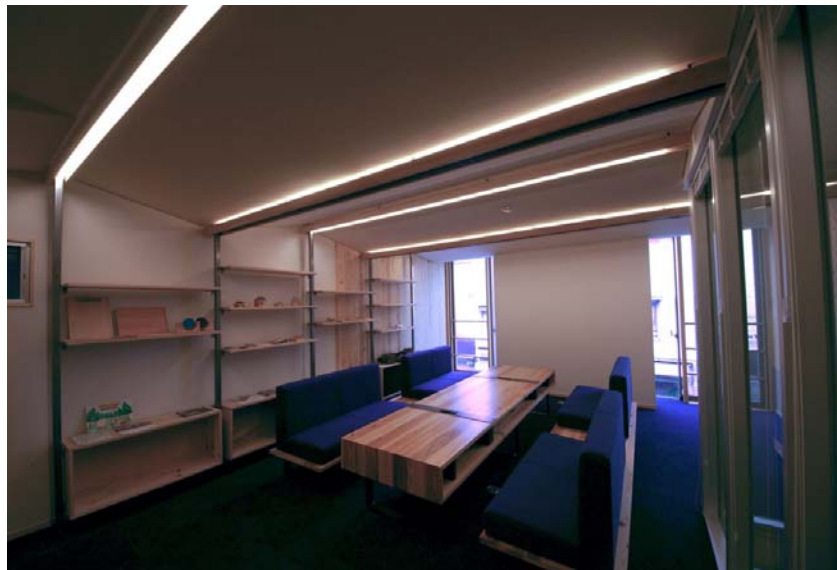
写真：現しとした CLT 壁パネルに棚を設置した例（高知の商業ビル）
