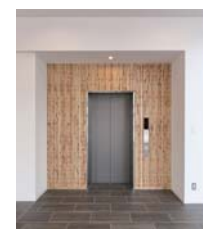
<CLT 内装壁材>
