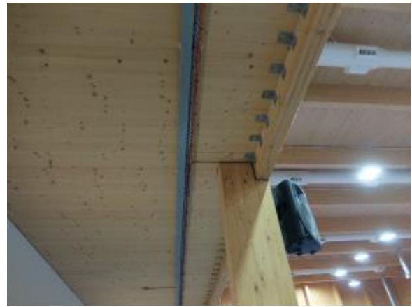
写真 7-7 露出された配線と L 型金物
