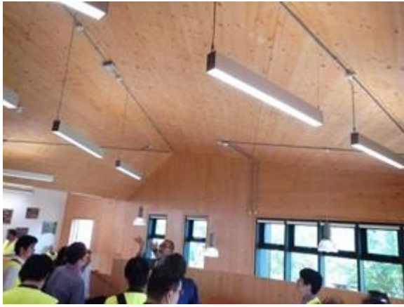
写真 3-4 折板構造の屋根
