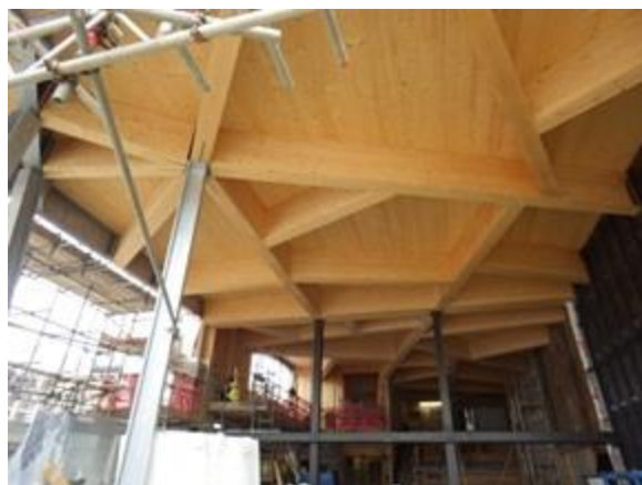
写真 9-2 キャノピー（エントランス庇）
