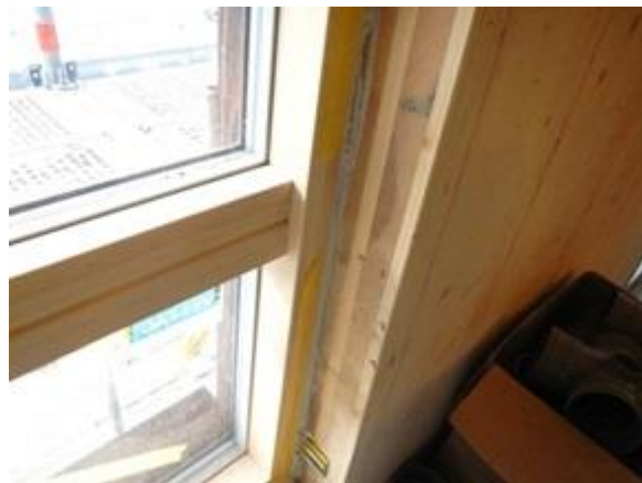
写真 3-25 木製サッシの納まり
