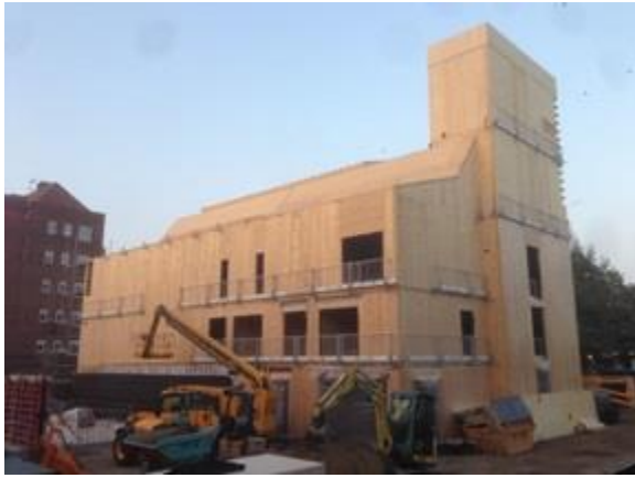
写真 4-9 建設中（右側煙突のような部分は高さ 20m）*4
