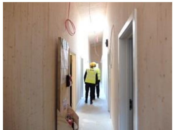
写真 3-18 居住棟の廊下部分（CLT は現し）
