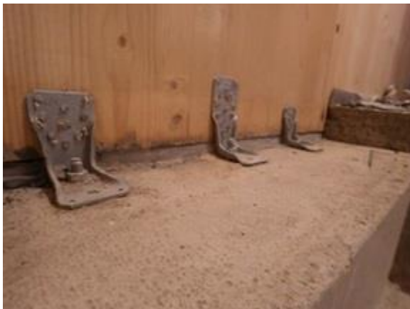
写真 9-7 CLT 壁－基礎間の接合
