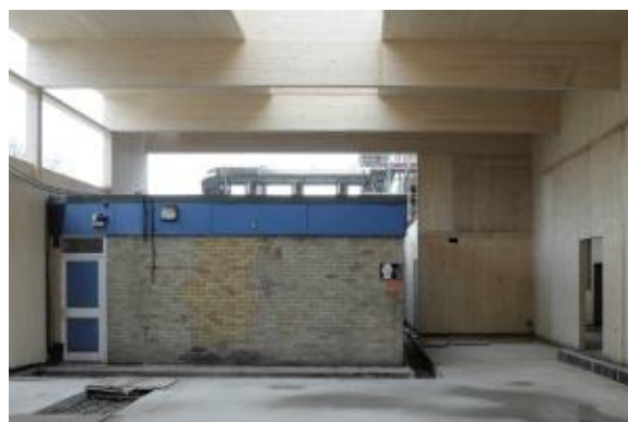
写真 4-3 内観（中央レンガ造は既存建物） *4
