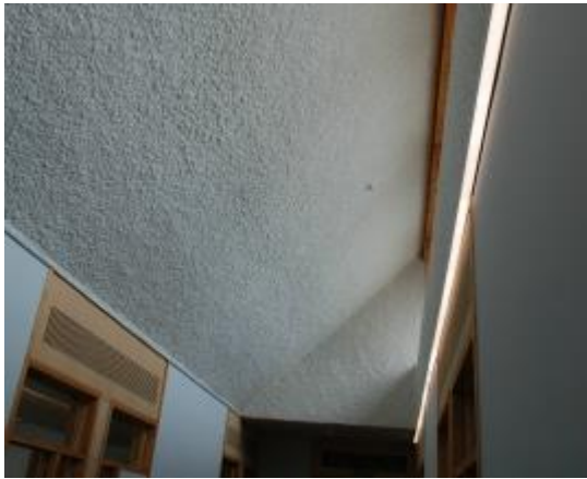
写真 7-5 天井には古紙を利用した、音や光を吸収できる内装材（断熱材厚さは 300mm）
