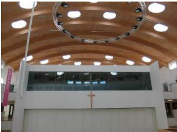
写真 6-7 天井は湾曲集成材に CLT を乗せている (CLT は 3 層 3 プライ、50mm)
