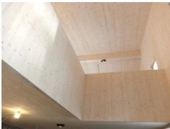
写真 3-11 吹抜け周りと屋根の現し CLT
