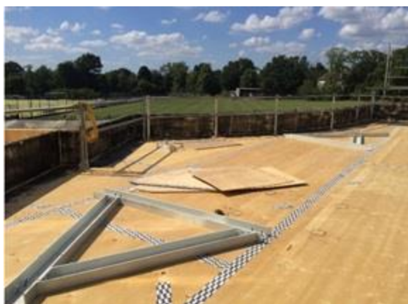
写真 4-14 建方中(屋根面)柱と床をつなぐ鉄骨補強がみえる*4
