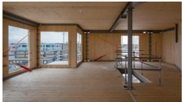
写真 1-6 鉄骨・CLT ハイブリッド構造の施工状況*2
