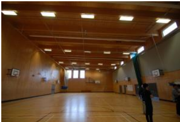
写真 6-10 体育館（高さ 8.5m、18m スパン）
