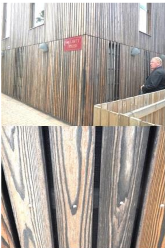
写真 3-8, 9 焼き板処理したカラマツ外装材
