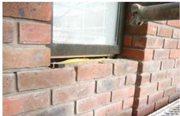
写真 3-26 外装レンガと開口部の納まり
