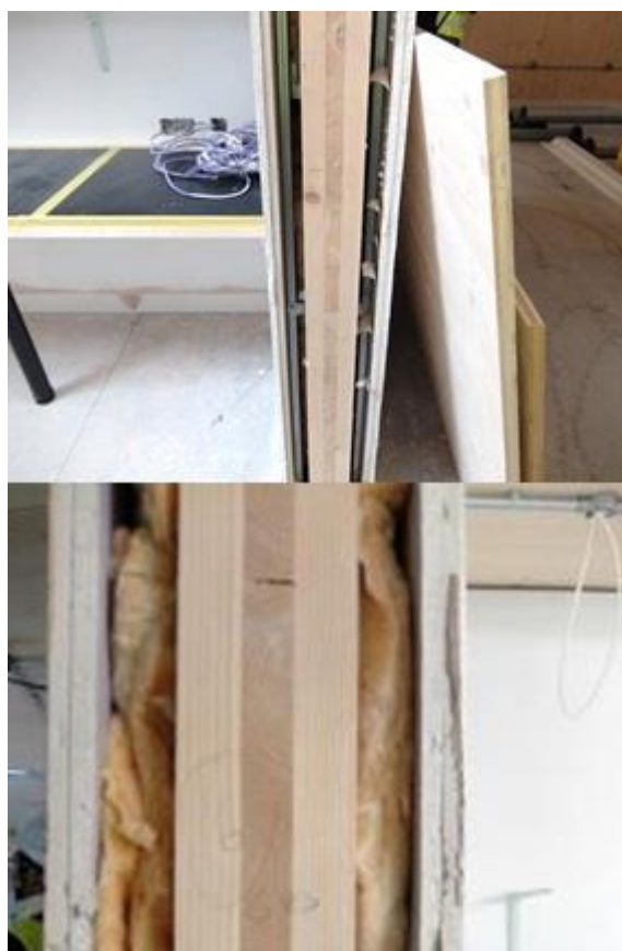
写真 3-27, 28 勉強室と共有スペースとの間仕切り壁（両面に石膏ボードを被覆）
