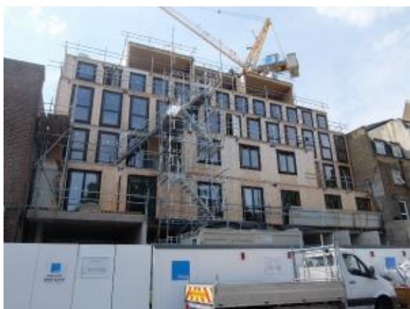
写真 16-1 工事中の現場
