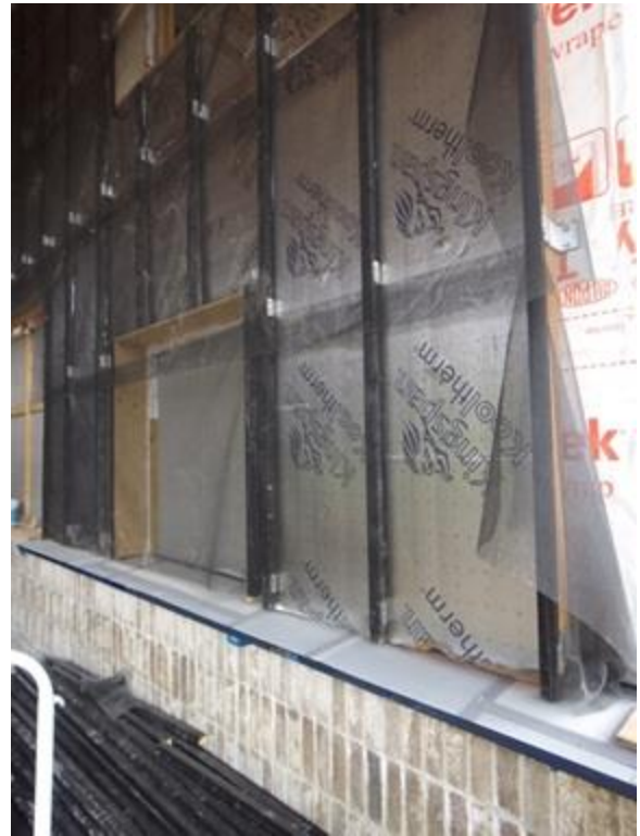
写真 9-8 外装下地（レインバリアシート）
