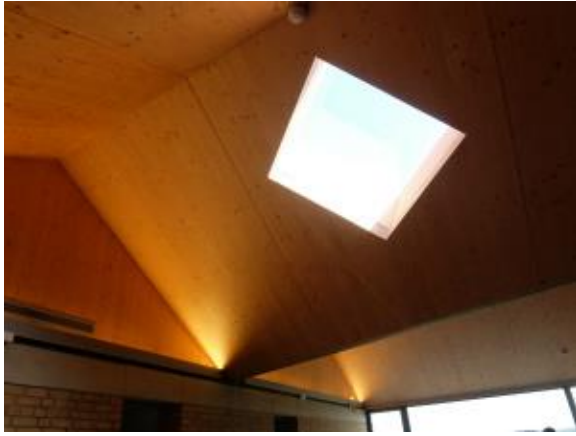
写真 11-12 天井開口（屋根の構成は CLT170mm+断熱材 230mm+垂鉛の屋根材。断熱材は屋根に仕込まれた樋の部分を削るがそのときに必要な数値を満足する厚さを確保）
