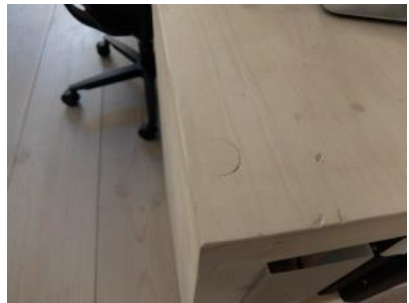
写真 18-15 接合部分は木栓で隠ぺい
