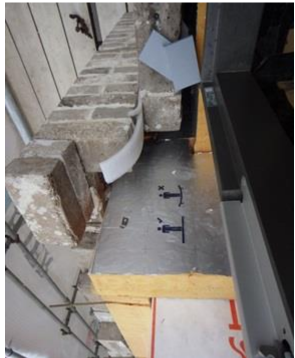
写真 9-9 外装レンガ積みの施工状況
