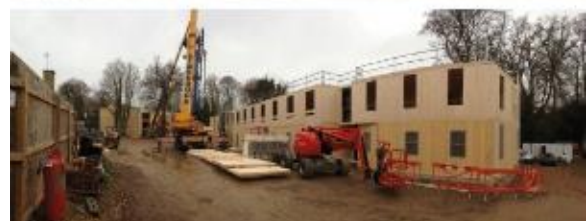
図 3-4 パネル組立作業 (現し CLT には黒色シートで被覆養生) *3
