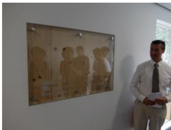
写真 7-11 CLT の壁は石膏ボード被覆だが、この部分はディスプレイ用に見せている（人物は説明してくださった Martin 氏）
