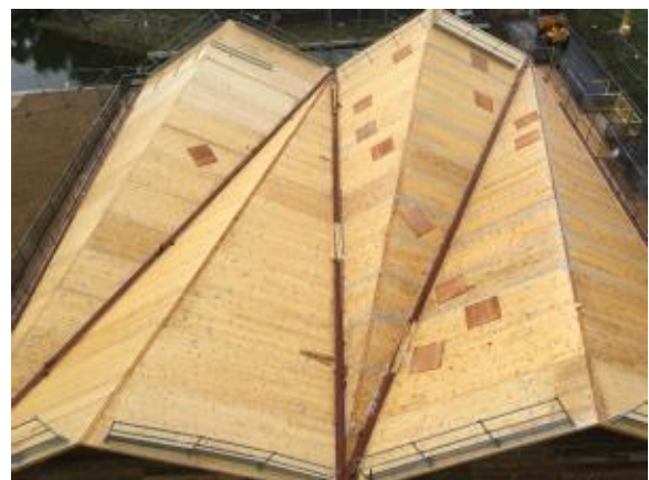
写真 11-5 建て方時の写真（屋根）*
