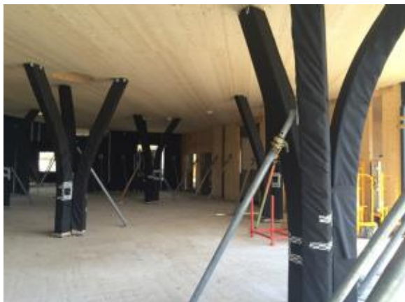
写真 4-13 建設時(柱は現しの為、養生)*4
