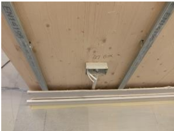
写真 3-32 石膏ボードで被覆される CLT 壁の鋼製下地フレームとコンセントボックス
