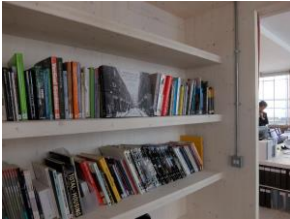
写真 18-16 本棚と間仕切り壁（配線は露出）
