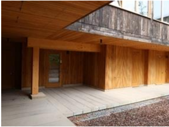
写真10-5 中庭側の1階は木材現しの仕上げ (こちらも樹種はオーク)
