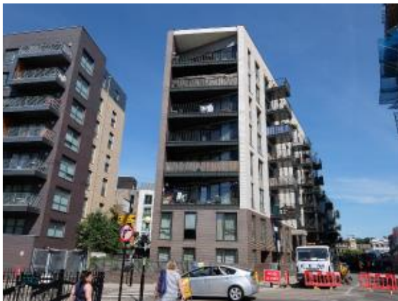
写真 13-1 外観 (中央の建物)
