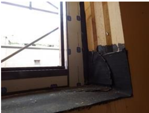
写真 9-11 開口部内側の気密施工
