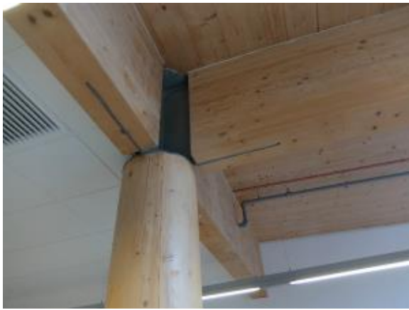
写真 6-8 集成材の柱と梁、接合金物
