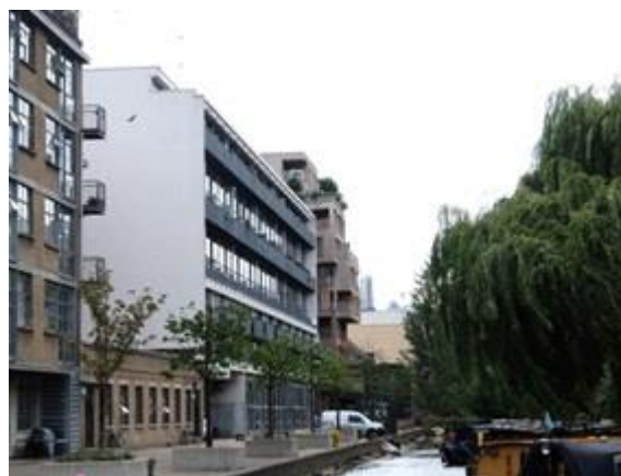
写真 1-4 外観 (建物裏側の運河に面した側から臨む、奥の凸凹のある建物)
