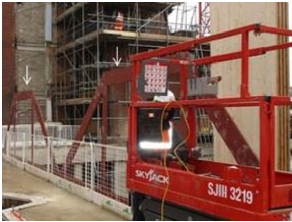
写真 9-6 CLT 壁内の鉄骨プレートトラス*7
