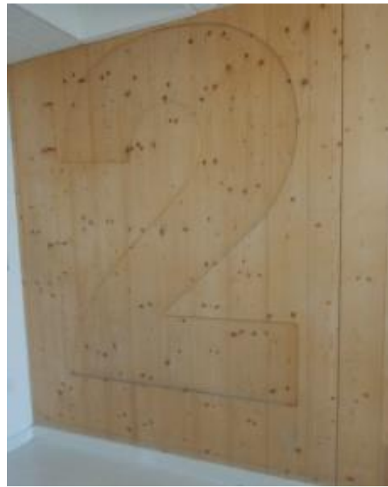
写真 6-11 階数を示すサイン(CLTに彫込み)
