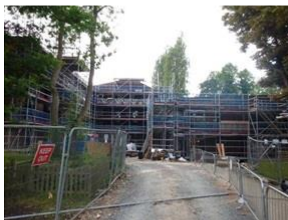
写真 3-10 保存樹木に囲まれた建設中建物
