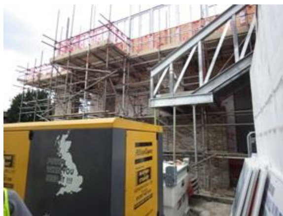
写真 9-1 外部仮設状況
