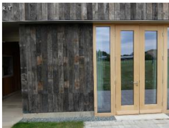
写真 10-3 外観(外装材は鉄道貨車の床材を再利用)
