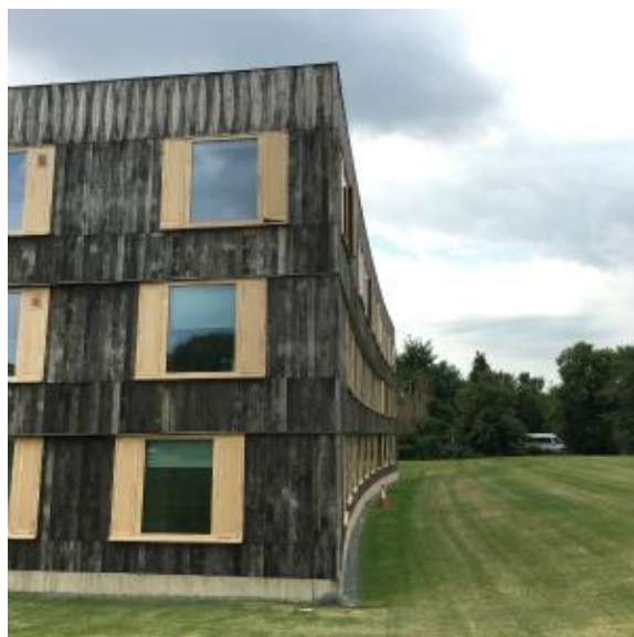
写真 10-2 外観(下の階程わずかに内側にカーブするようデザインされている)
