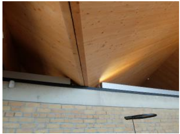
写真 11-9 屋根と梁の接合部（CLTと梁は接点において金物接合されているが、室内側からは隠れるように施工）
