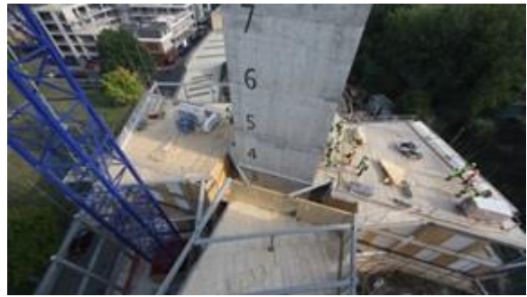
写真 1-5 RC コアと鉄骨・CLT ハイブリッド構造の施工状況*2
