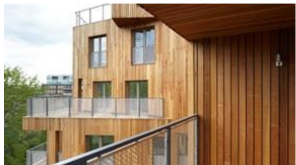
写真 1-8 ウエスタンレッドシダーによる外装材*2
