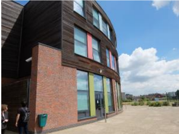
写真 6-6 外観 (1 階部分はレンガ、2~3 階部分は木の外装)
