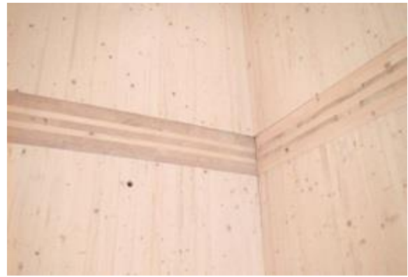
写真 3-17 階段室で見られた床 CLT パネルの木口断面（5 層 7 プライ構成）
