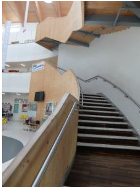
写真 6-5 階段の手すりも 50mm の CLT を曲げて利用
