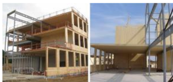
図 5-2 施工時（外周 CLT、内部鉄骨）*5
