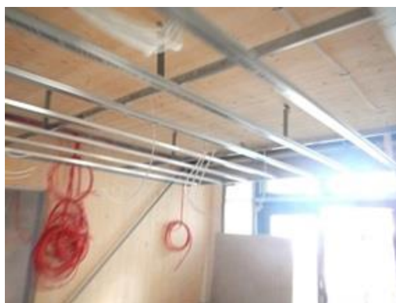
写真 3-29 二重天井の下地フレーム
