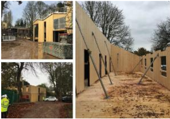
図 3-5 パネル組立作業（隠蔽される CLT には配慮なし）*3
