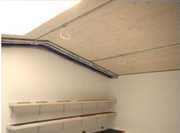
写真 3-30, 31 配線の納め方
