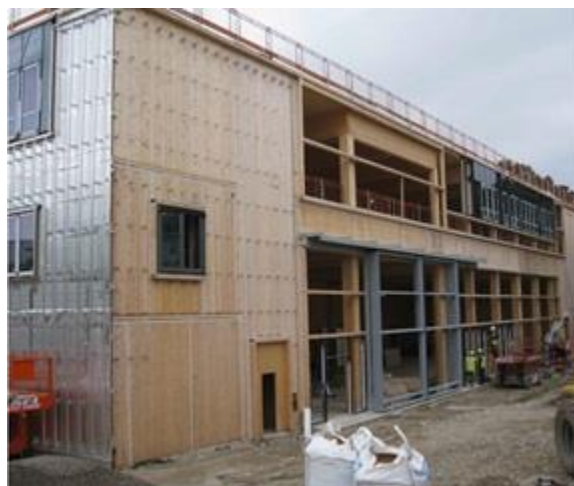
写真 5-3 建設時 (CLT, 集成材, 鉄骨が見える)
