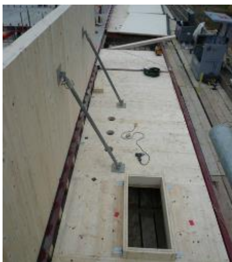
写真 4-5 建設時（建設中に利用される壁のサポート材）*4
