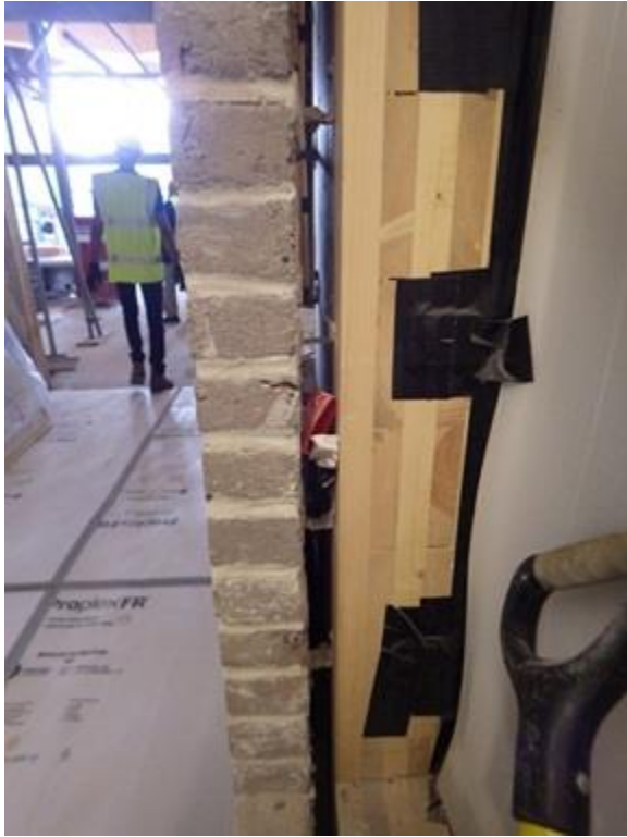
写真 9-10 内装レンガ積み 施工状況
