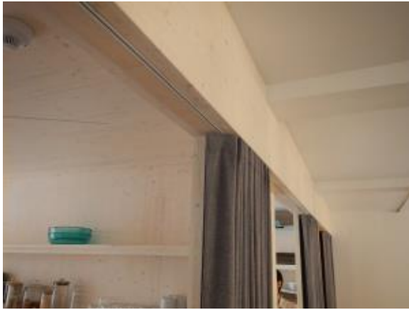
写真 18-10 カーテンレール
