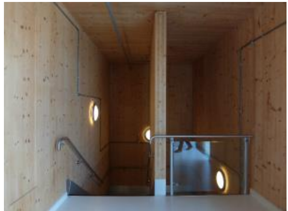
写真 6-7 階段室 (手すりや配線は CLT に直接設置)
