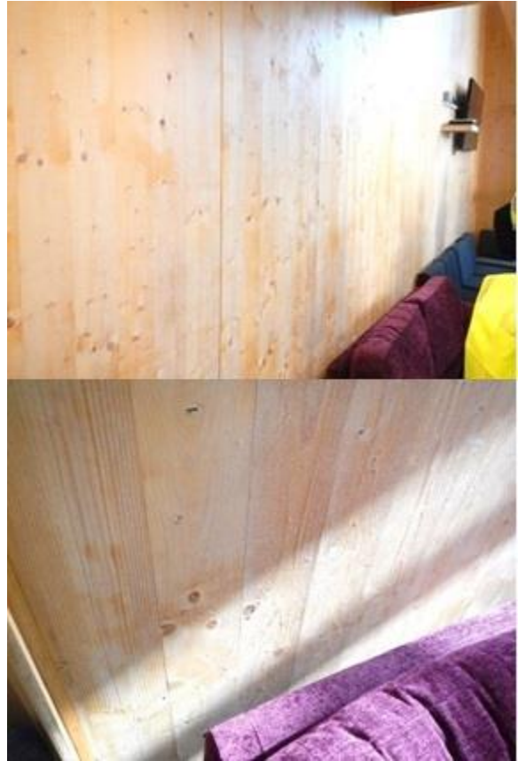
写真 3-5,6 防火塗料が塗られた CLT の色ムラ
