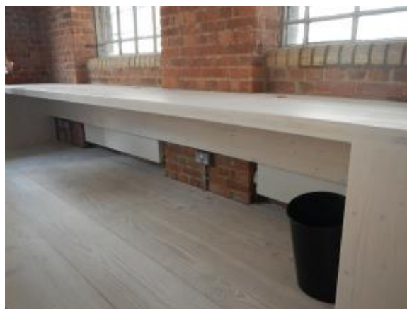
写真 18-8 もともとレンガ造の倉庫を改修
