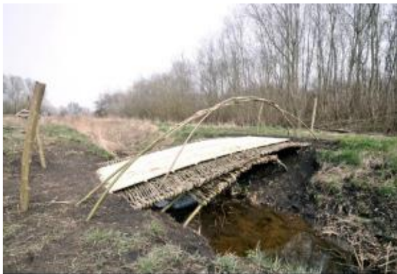
図 8-2 柳の枝を編んでくみ上げた橋 *8
