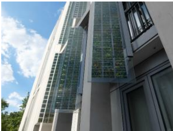
写真 18-20 ファサードに設置された太陽光パネル
