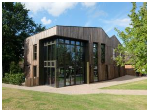
写真 3-1 増築部分の外観
