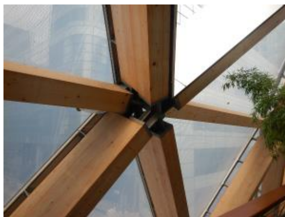
写真 18-3 集成材と接合金物
