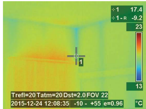
図 4. 2. 1-21 室内④ 1階子供室北西サーモ画像
