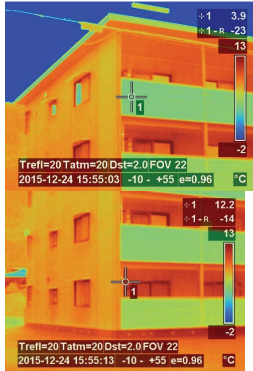
図 4.2.1-7 外観①（南西面）サーモ画像
