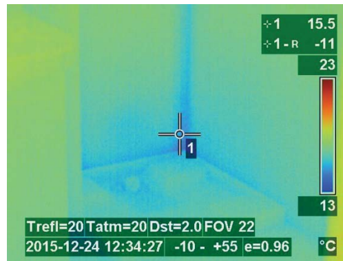
図 4. 2. 1-39 室内⑬ 3階寢洗面室北サーモ画像
