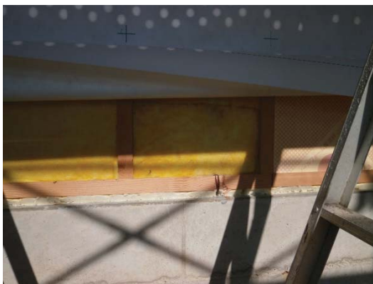
図 4.2.3-6 1 部 (断熱材復元)
