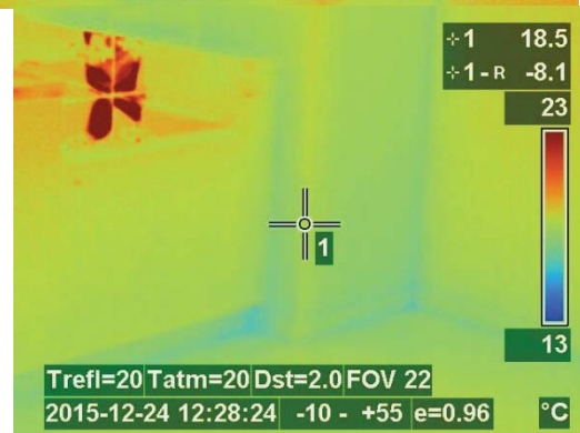
図 4. 2. 1-31 室内⑨ 3階キッチン西サーモ画像
