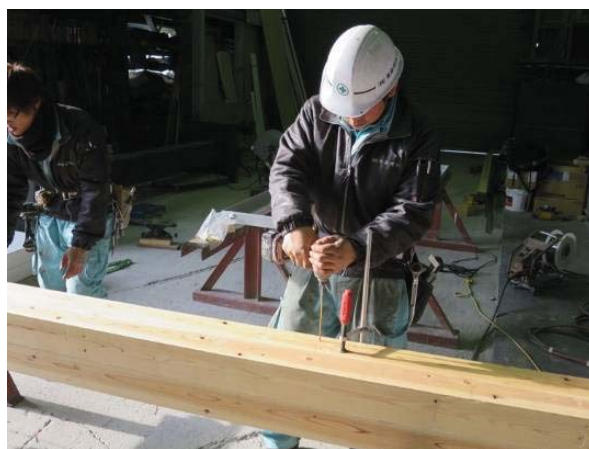
写真 5.2.2-4 建築用ビスの打ち込み風景
