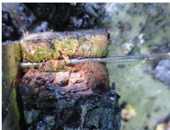
写真 5. 2. 4-14 接合具が接する木材の状況 (TC-2)
