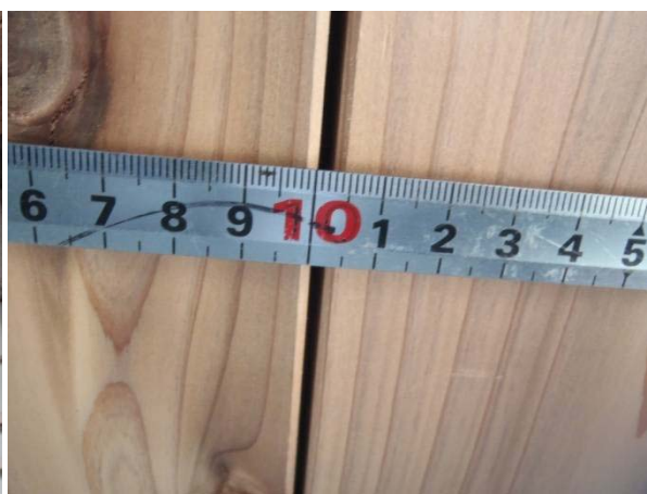
写真5. 1. 4-2 はり間のクリアランス
