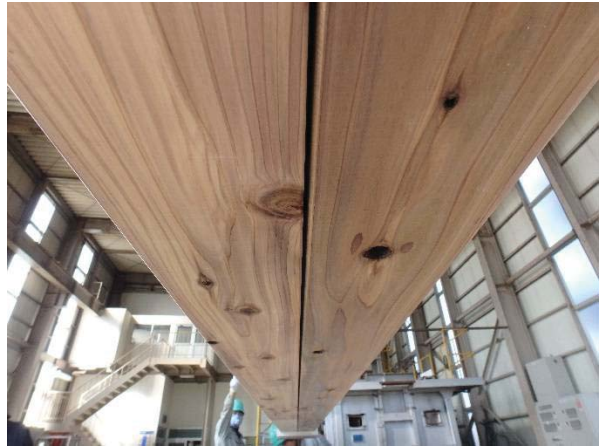
写真5.1.4-18 はり間のクリアランス
