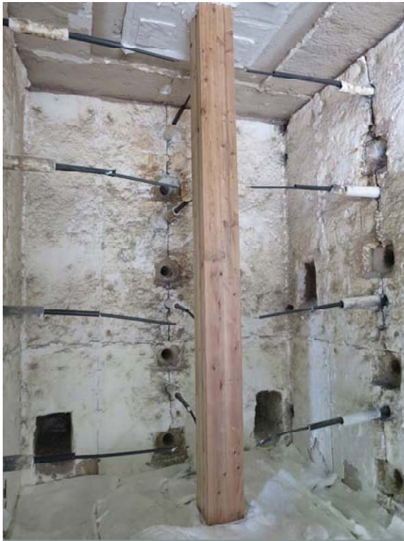
図 5.2.3-1 構造用集成材を使用した 合わせ柱の設置状況
