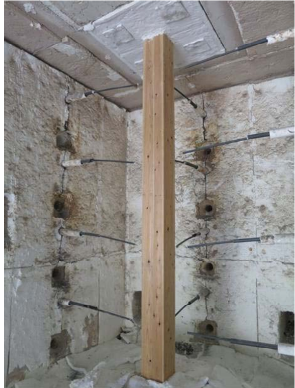
図 5.2.3-2 構造用製材を使用した 合わせ柱の設置状況
